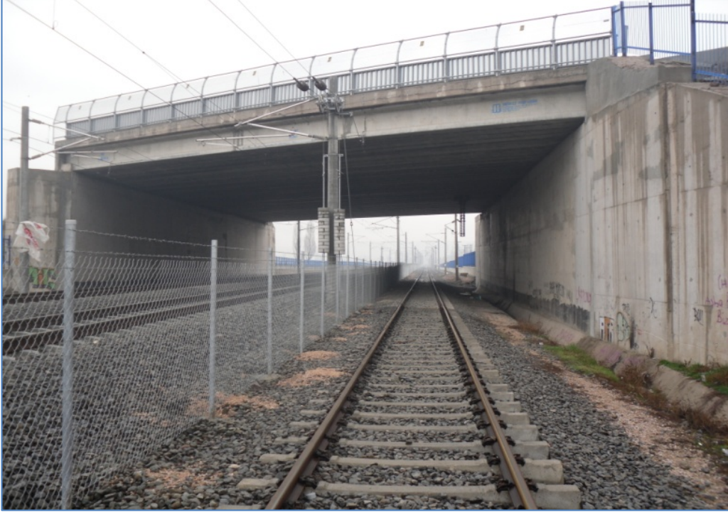
Şekil 2. 3 : Ankara-İstanbul Yüksek Hızlı Demiryolu (YHD) Hattı İhata Uygulaması
