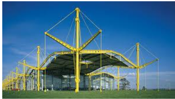
Şekil 17 Renault Distribution Centre Binası-(URL-2020)
