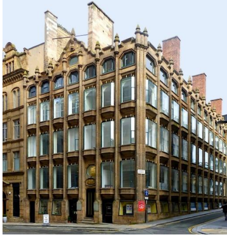
Şekil 8 Oriel Chambers Binası-(URL-2020)
