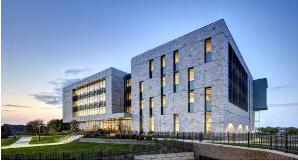
Şekil 30 Ağır Giydirme Cephe Örneği-(URL-2020)
