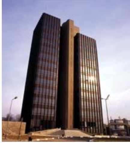
Şekil 18 Karayolları 17. Bölge Müdürlüğü Binası-(URL-2020)
