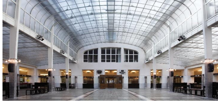
Şekil 10 Post Office Saving Bank Binası-(URL-2020)
