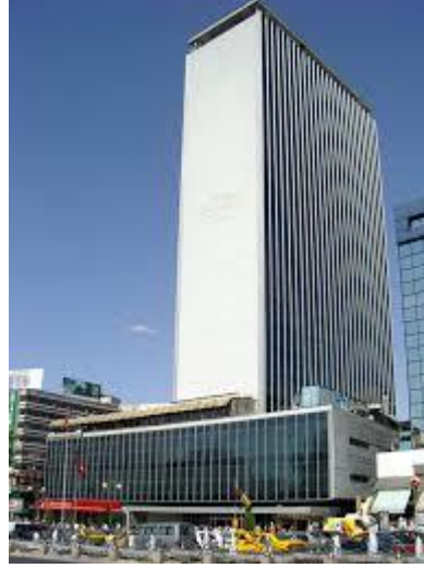
Şekil 16 Kızılay İşhanı Binası-(URL-2020)
