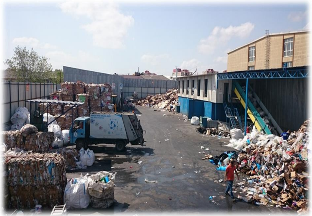
Şekil 6.1: Tesis Genel Görünüm
