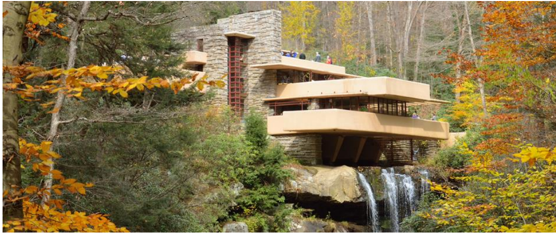
Şekil 1.1: Frank Lloyd Wright'ın Fallingwater projesi. A- Arazinin topoğrafik haritası, B- Binanın yerleşimi üçgenle gösterimi, C- Binanın harita üzerinde gösterimi (Weisberg, 2011. URL-1).
