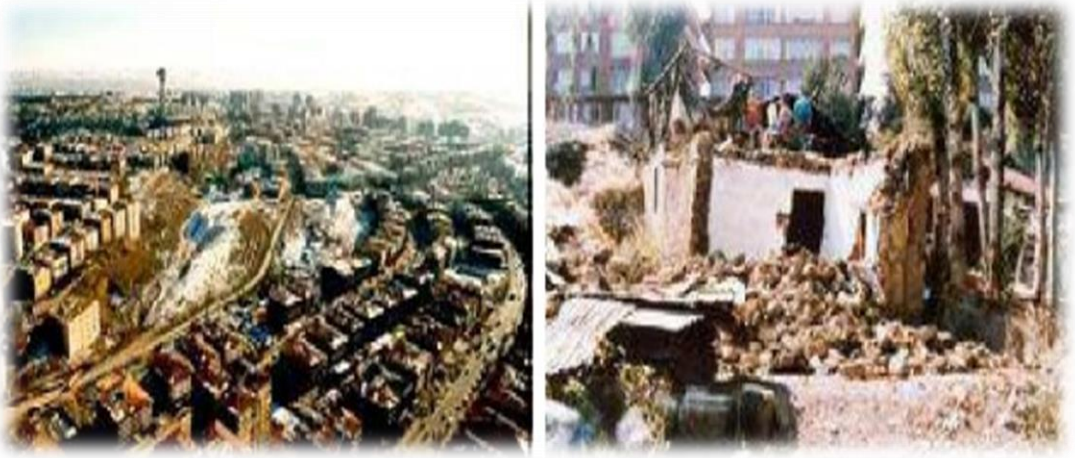
Şekil 4. Ankara Portakal Çiçeği Vadisi Yıkım Çalışmaları (Kaban, 2011, s.17).
