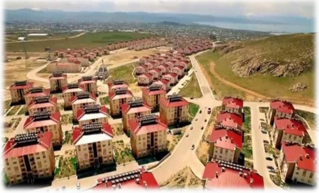
Şekil 6. Van Depremi Sonrası Yapılan Kalecik Toplu Konut Alanı (Doğanay, 2016, s.109).
