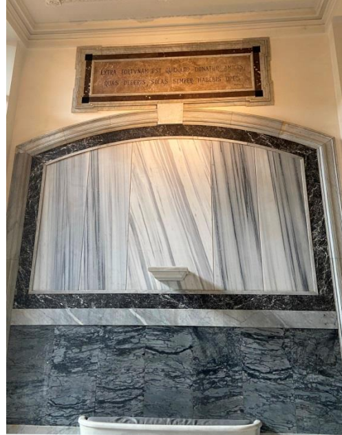
řekil 32 Salt Galata giriř hol mermer kaplama duvar detayı (Davutođlu D., 2022)
