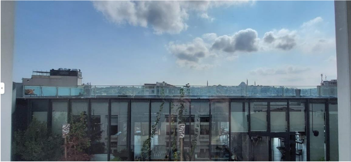
Şekil 123 Salt Galata ek yapının ana binadan görünümü (Davutoğlu D., 2022)
