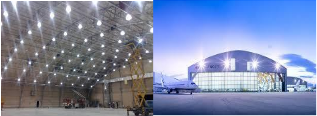
Şekil 63. Uygun Işık Kaynağı, Zemin Ve Çatı Dizaynı İle Aydınlatılmış Uçak Bakım Hangarı
