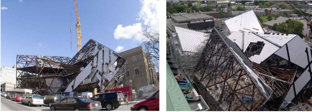
Şekil 66 Kompozit ve çelik cephe montajı [URL-35]
