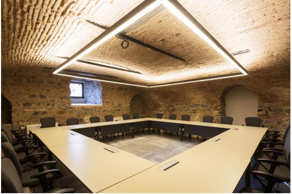
Şekil 22 Beyoğlu belediye binasının yenilenen elektrik tesisatı [URL-13]
