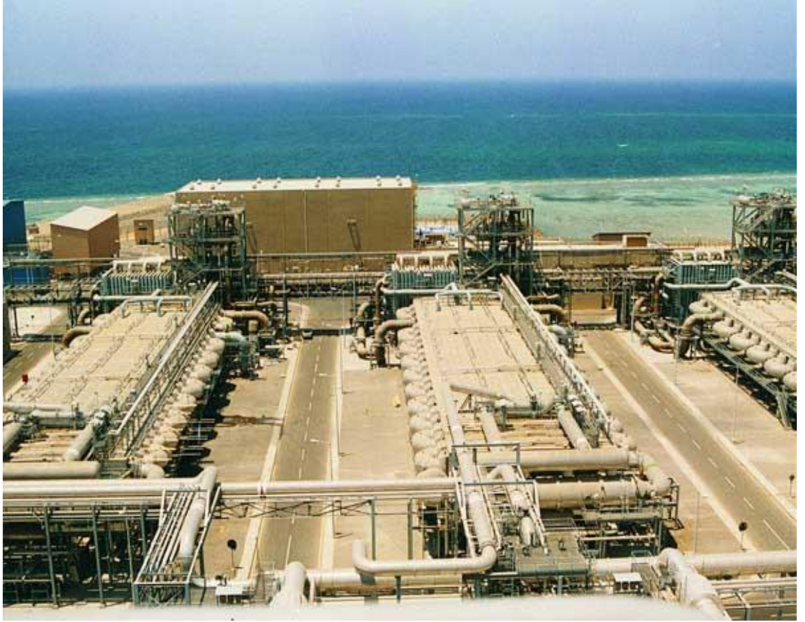
Şekil 4.2: Al Jubail Deniz Suyu Arıtma Tesisi-Suudi Arabistan (Url-1)
