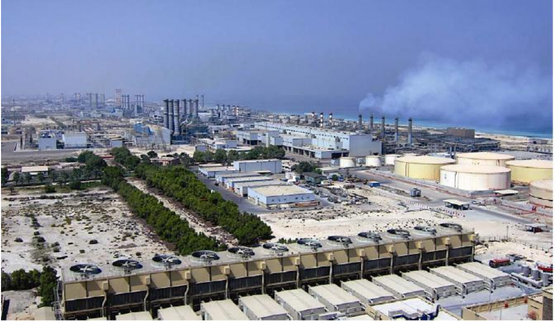
Şekil 4.5. Dubai Jebel Ali-M Deniz Suyu Arıtma Tesisi (Yıldız, 2012).
