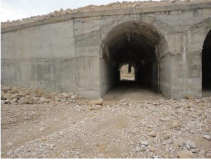
Şekil 3.1: Proje İle İlgili Köprü Yapım Operasyonu
