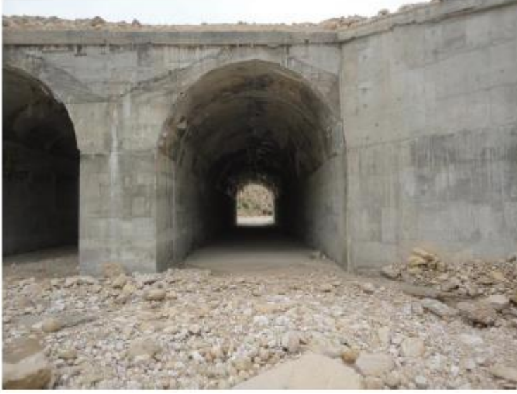
Şekil 3.3: Proje İle İlgili Köprü Yapım Operasyonu
