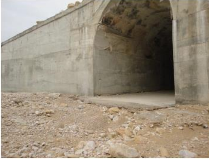
Şekil 3.2: Proje İle İlgili Köprü Yapım Operasyonu
