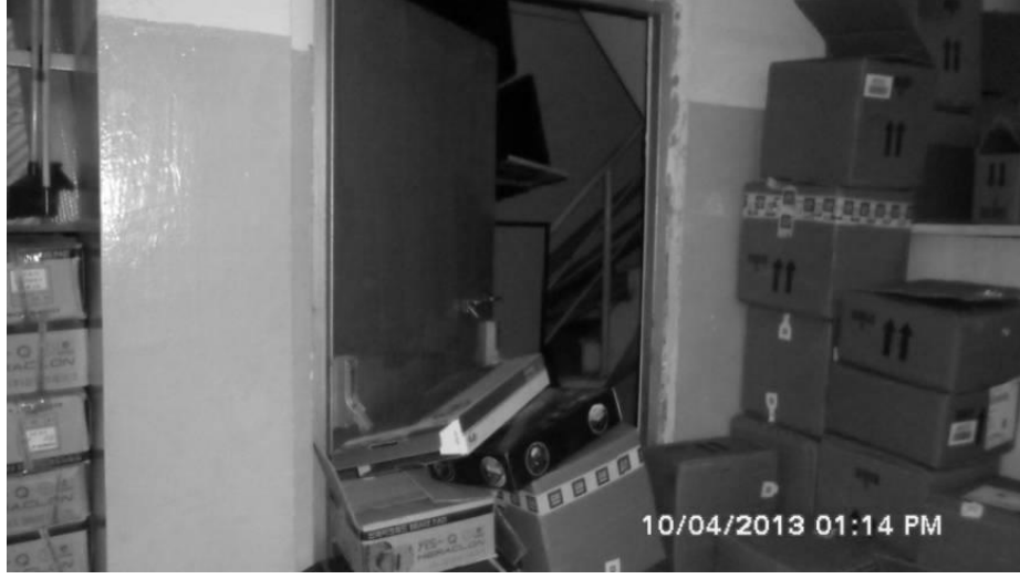
Şekil 2.11: Düzenleme yapılmadan önce bir yangın çıkışı(Kaporta Bölümünden)
