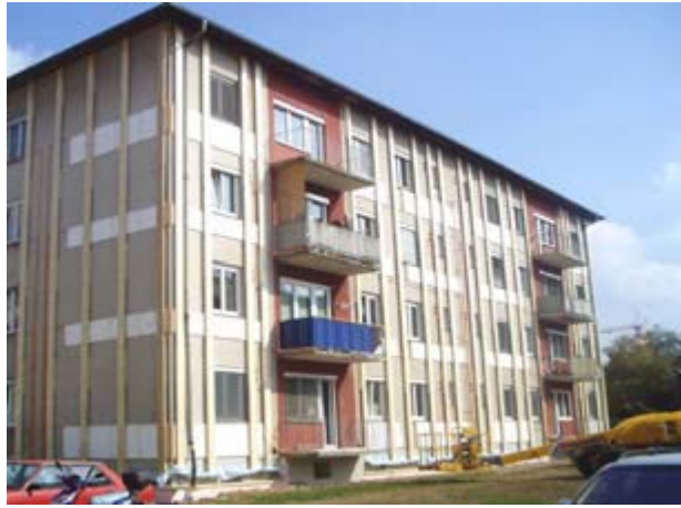
Şekil 1.10: Mevcut cephelere takılan ısı dağıtım ve XPS panoları [Url-1]
