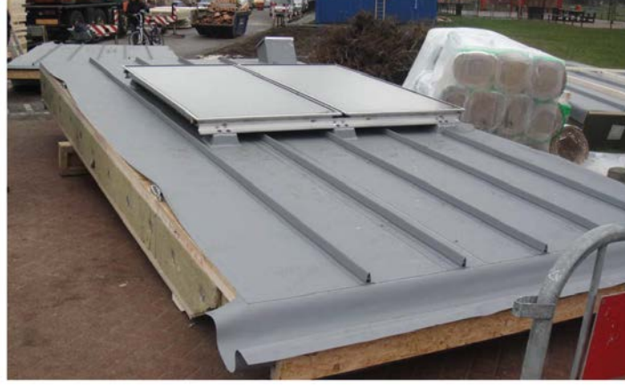
Şekil 1.19: Fabrikada monte edilen güneş enerjisi termal kollektörü ile prefabrik çatı elemanı[14].
