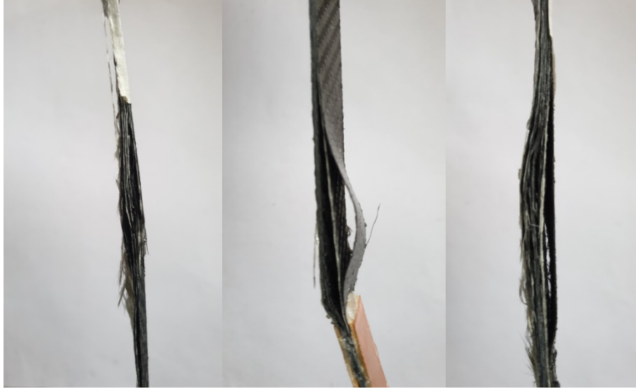
Şekil 5.12: Numunelerde meydana gelen hasar modları
