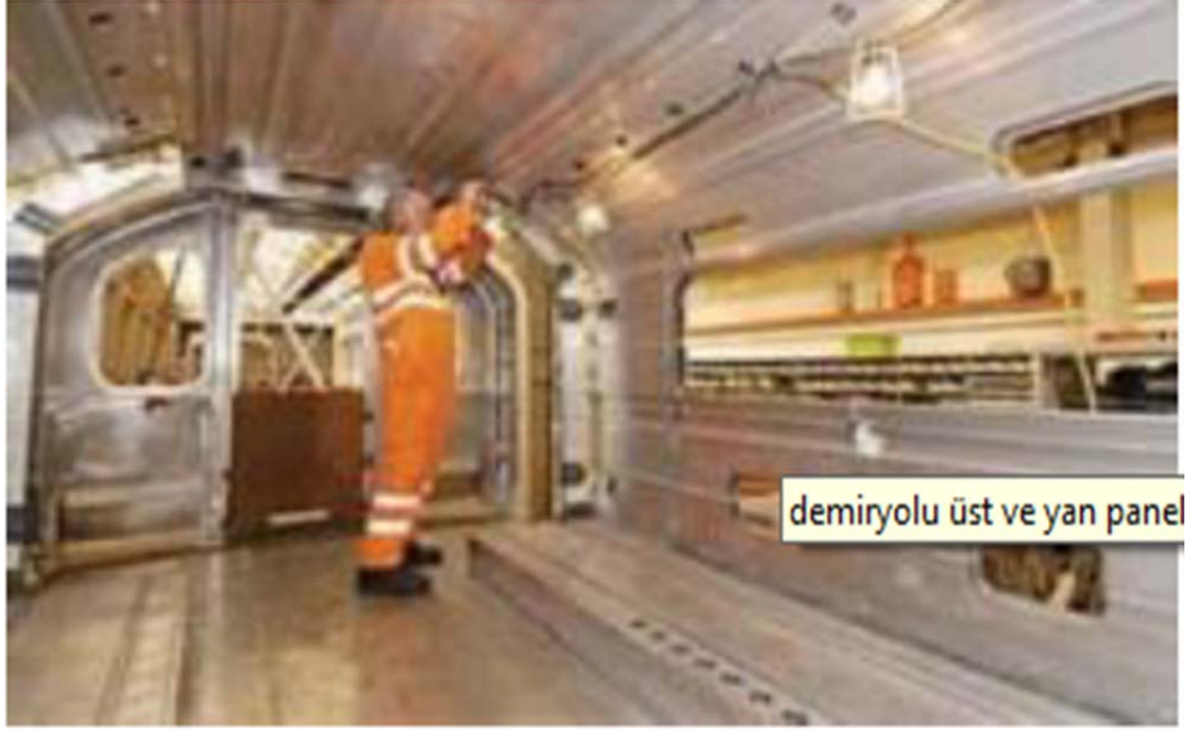
Şekil 2.6: Tren yapımında SKK kullanımı
