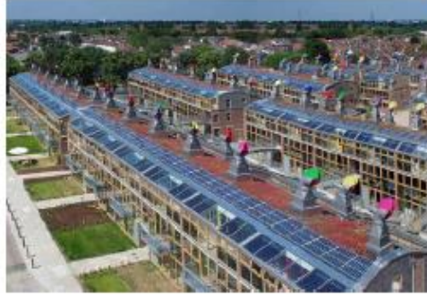
Şekil 4.9: İngiltere, Londra BedZED PV uygulaması [URL-7].
