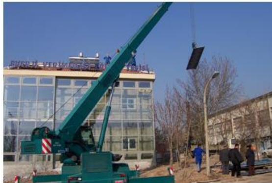
Şekil 4.16: YEGM parkı tesis binası fotovoltaik panel montajı [URL-14]
