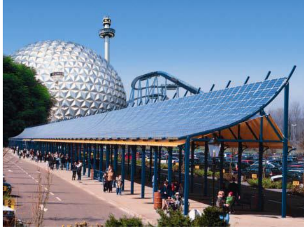
Şekil 4.13: Europa Park Rust, Almanya PV uygulaması [URL-11]
