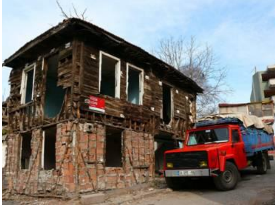
Resim 4.22: Sulukule eski mimari özelliđi, ahşap iskeleli hımış yapılar
