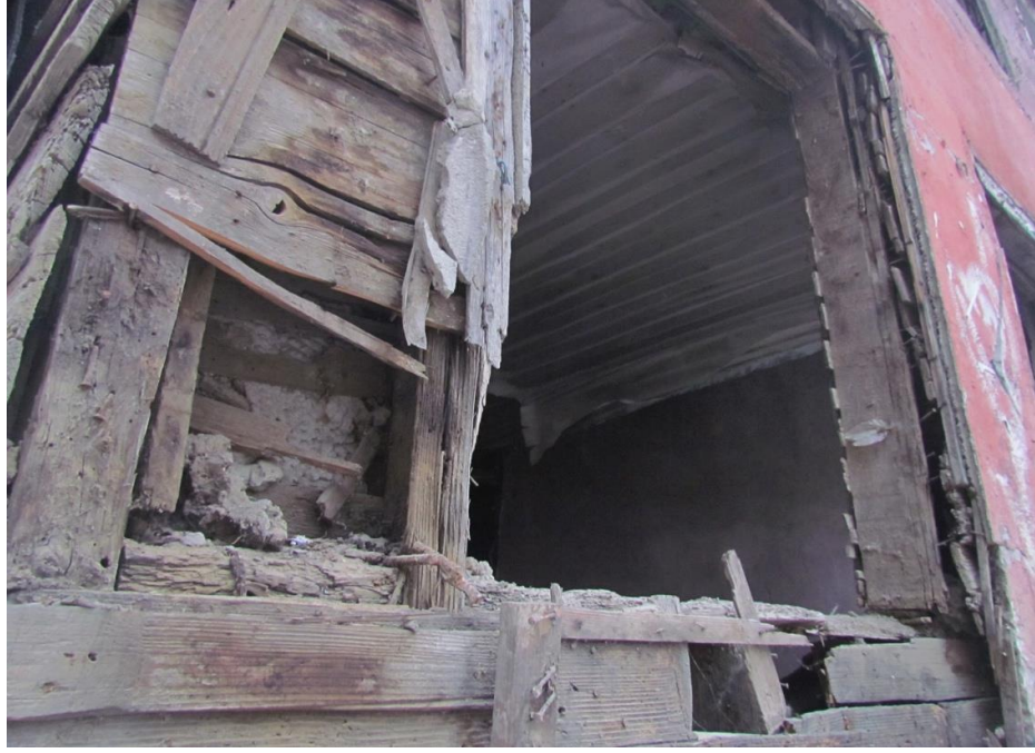
Resim 4.21: Sulukule eski mimari özelliđi, ahşap iskeleli hımış yapılar
