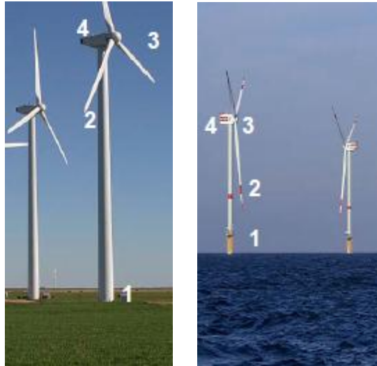
Şekil 1.1: Bir rüzgar türbininin ortak bileşenleri : (1) kule, (2) bıçak, (3) göbek ve (4) nacelle.
