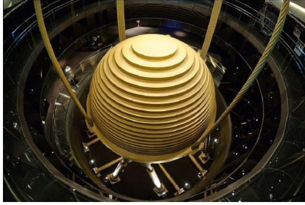
Şekil 16 : Taipei 101 TMD (A)
