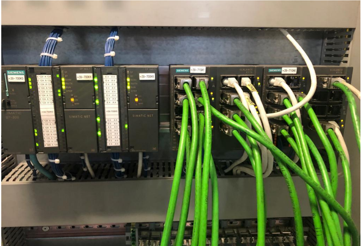
Şekil 73 Pano İçerisinden CPU-I/O Modül-CP343-1 Lean-Scalance Bağlantı Görüntüsü
