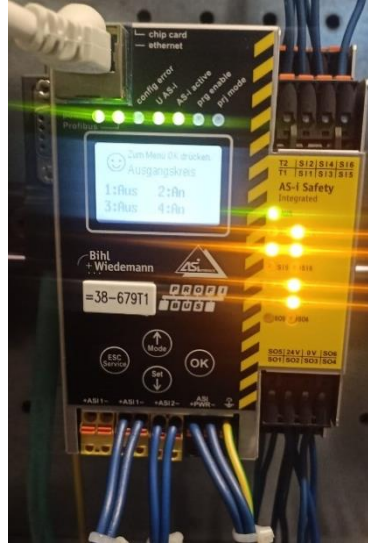
Şekil 16 Pano içi Kullanıma Örnek AS-I Interface Modül
