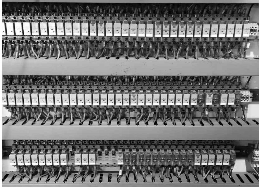
Şekil 34 Röle ile Kontrol Sistemi
