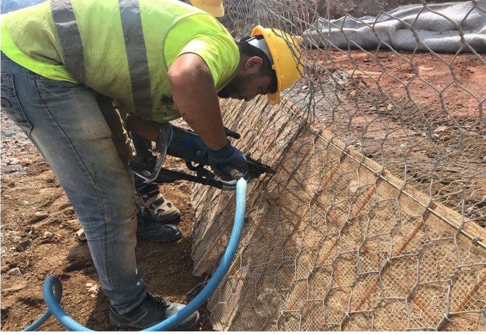
Şekil 4.8. Pnömatik tabanca ile halka birleştirme işlemi
