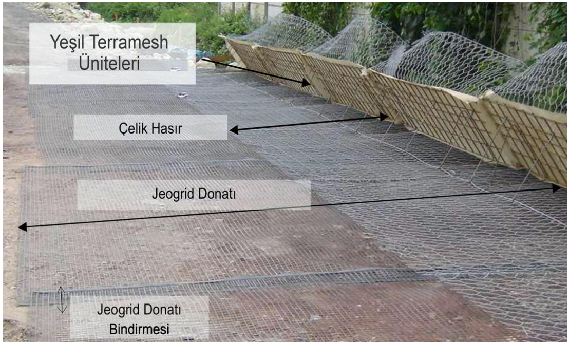
Şekil 4.5. Geogrid donatılarla güçlendirilmiş zemin katmanları
