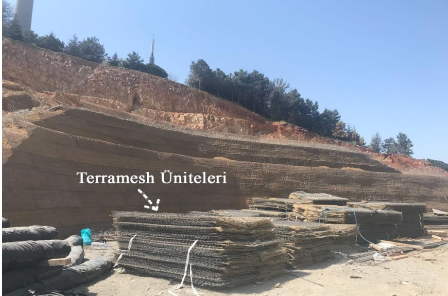
Şekil 4.9. Kapalı halde şantiyeye gelen terramesh üniteleri
