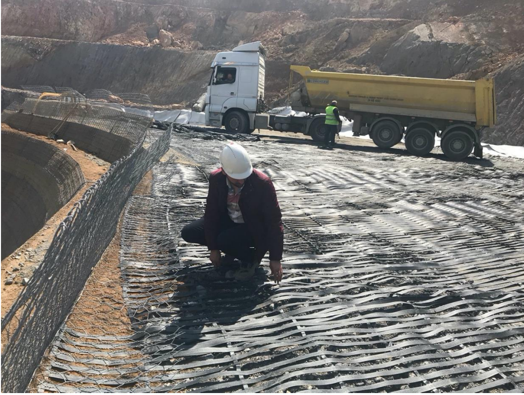
Şekil 4.11. Geogrid donatılarının yerleştirilmesi işlemi
