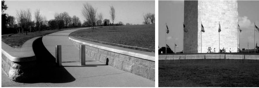
Şekil 6. Washington anıtı çevresi duvarları Emniyet mesafesi
