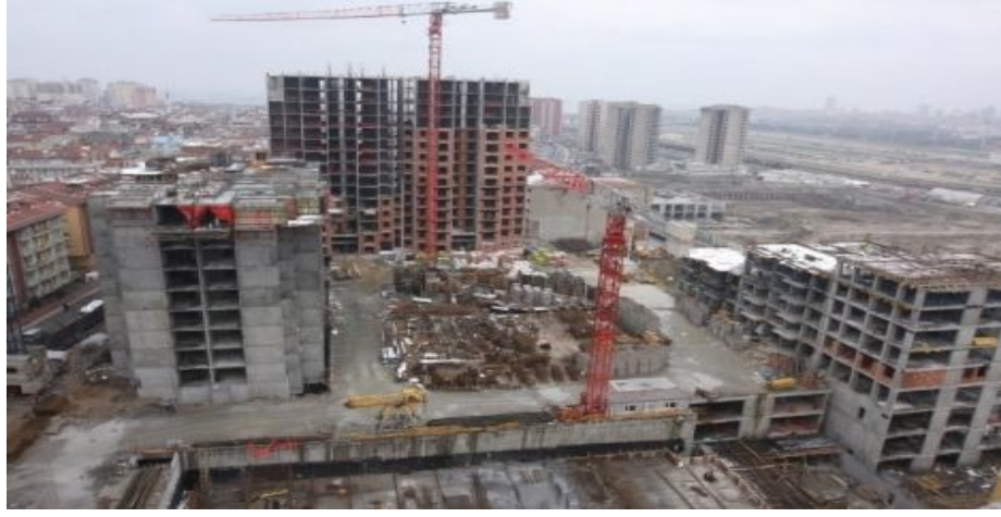
Şekil 3.1: Sümer Mahallesi Yıkım Çalışmaları [56]
