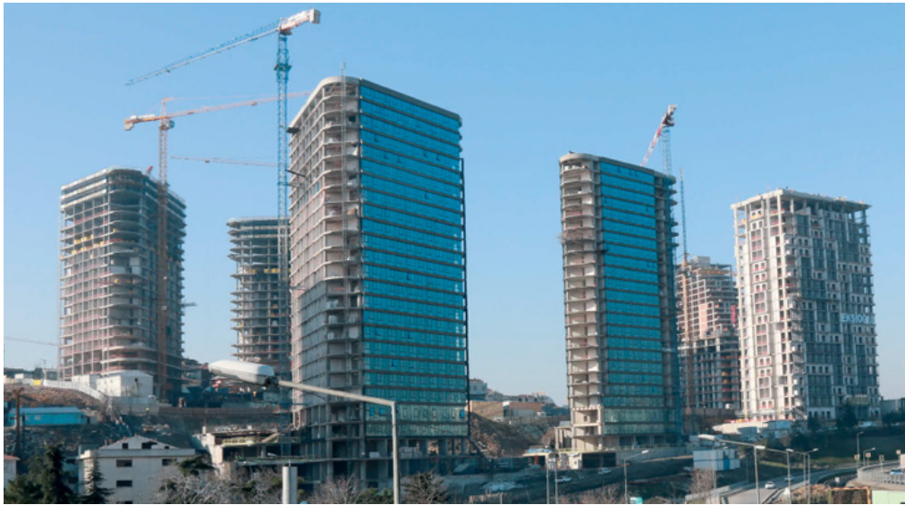
Şekil 4.9: Fikirtepe Dikey Yapılaşma Örnekleri [71]
