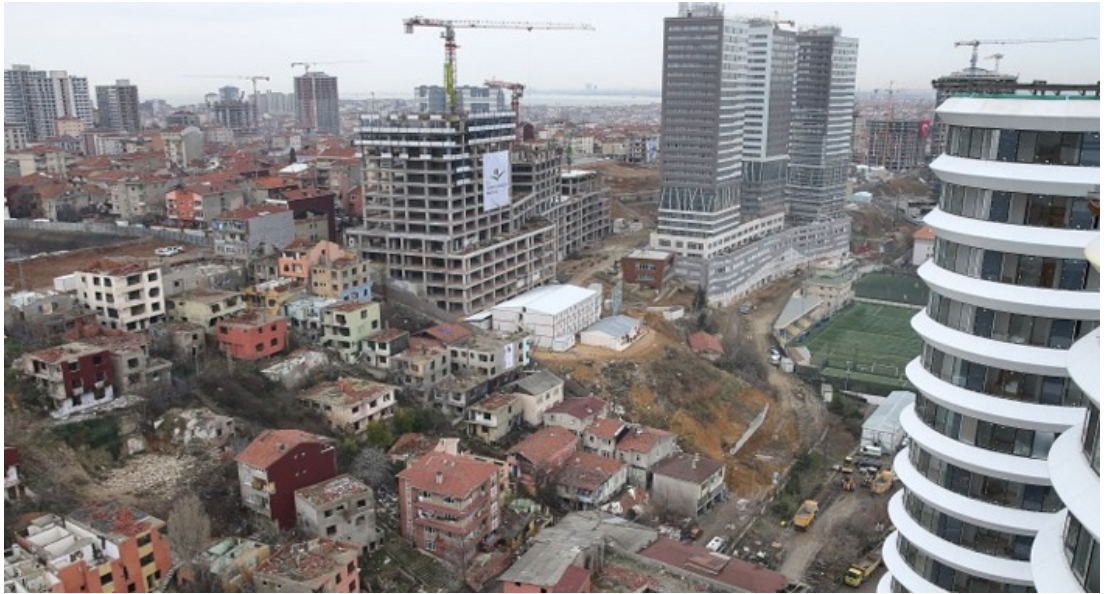
Şekil 4.10: Fikirtepe Eski ve Yeni Yapılar [72]
