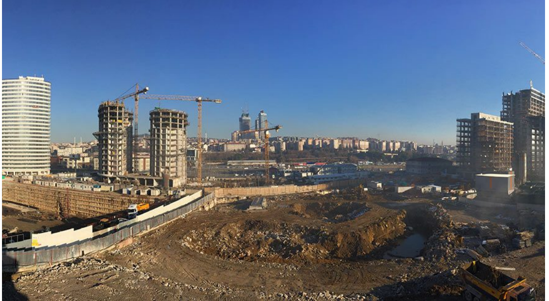
Şekil 4.6: Fikirtepe İnşaat Alanları [68]
