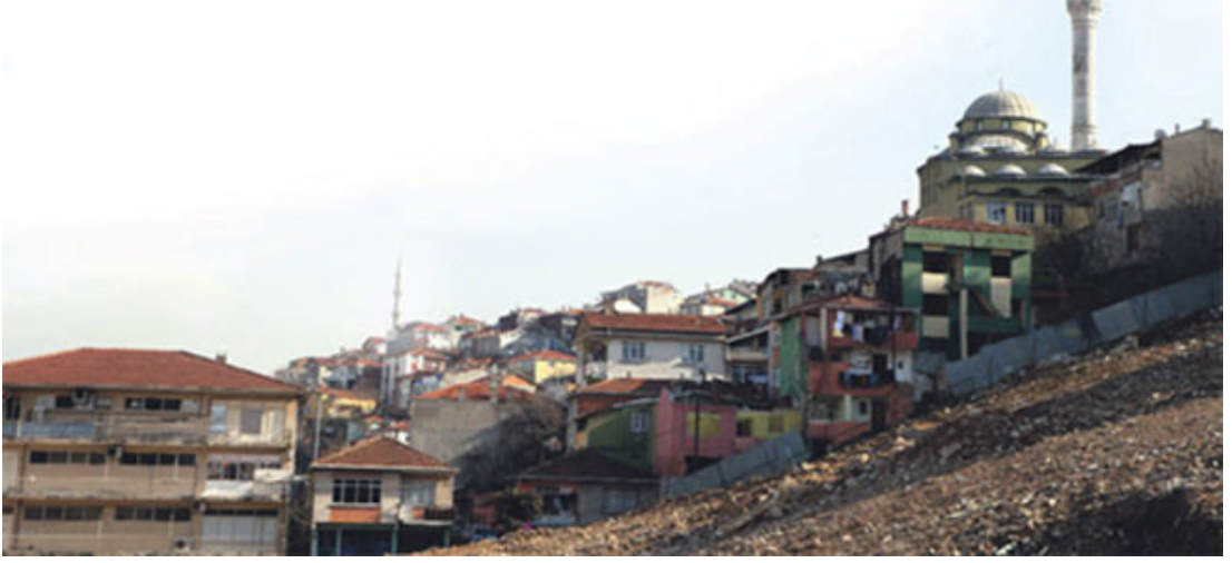
Şekil 4.3: Fikirtepe Kentsel Dönüşüm Proje Öncesi Yapılar [65]
