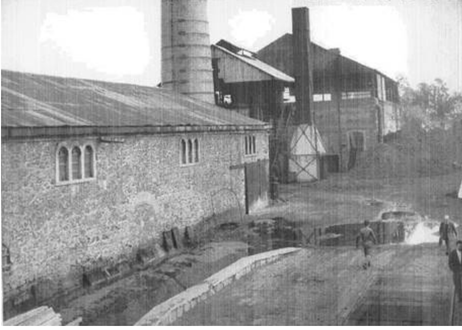
Şekil 4.39: Dökümhane Yapısı ve Fırırlar [53]
