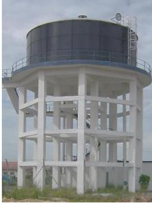
Şekil 1.1: Kolon ve kirişlerle desteklenen su tankı [1].
