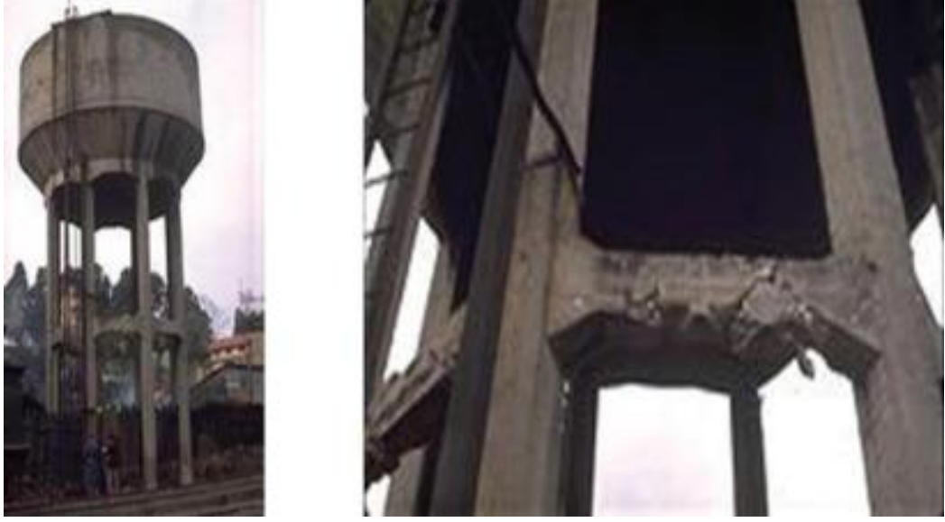
Şekil 2.2: 50 m 3 kapasiteli yükseltilmiş su deposu, Şili depremi [2].
