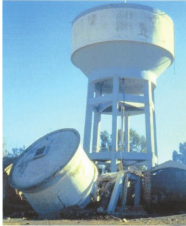
Şekil 2.8: Cezayir El-Asnam depreminden sonra su tankı [2]
