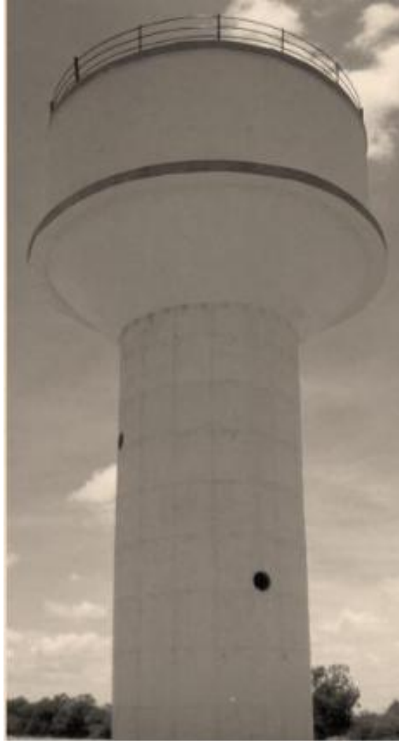
Şekil 1.2: İçi boş dairesel şaft tipi su tankı [1].
