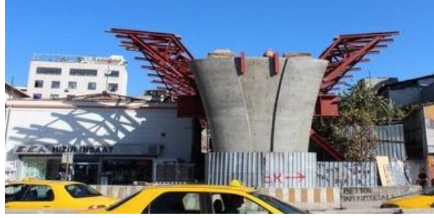
Resim 7 – Hamamın 4 metre önünde yer alan Haliç Metro Köprüsü ayağı
