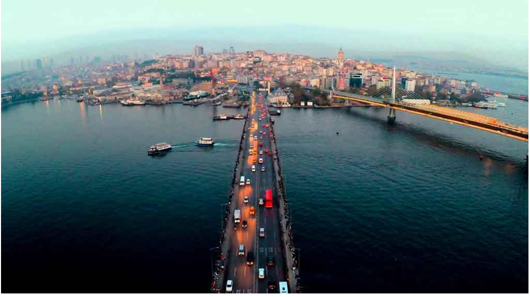
Şekil 4.16: Atatürk (Unkapanı) Köprüsüne Ait Görüntü
