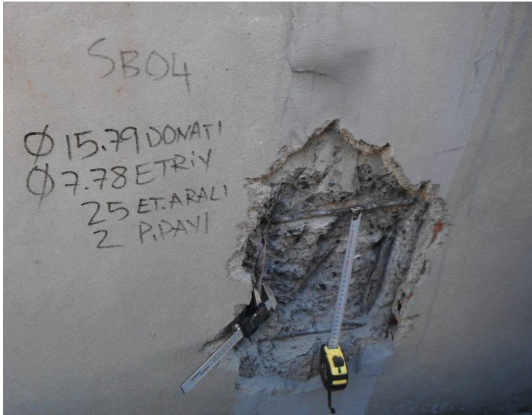
Şekil 3.25 : Tahribatlı yöntem (sıyrma) ile donatı tespiti işlemi
