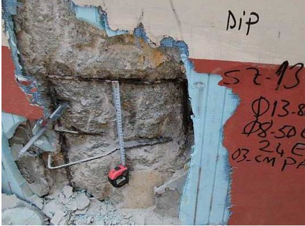
Şekil 3.24 : Tahribatlı yöntem(sıyrma) ile donatı tespiti işlemi
