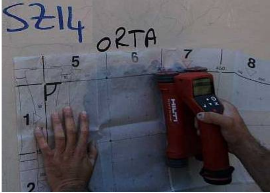
Şekil 3.34 : Tahribatsız yöntem (röntgen taraması) ile donatı tespiti işlemi
