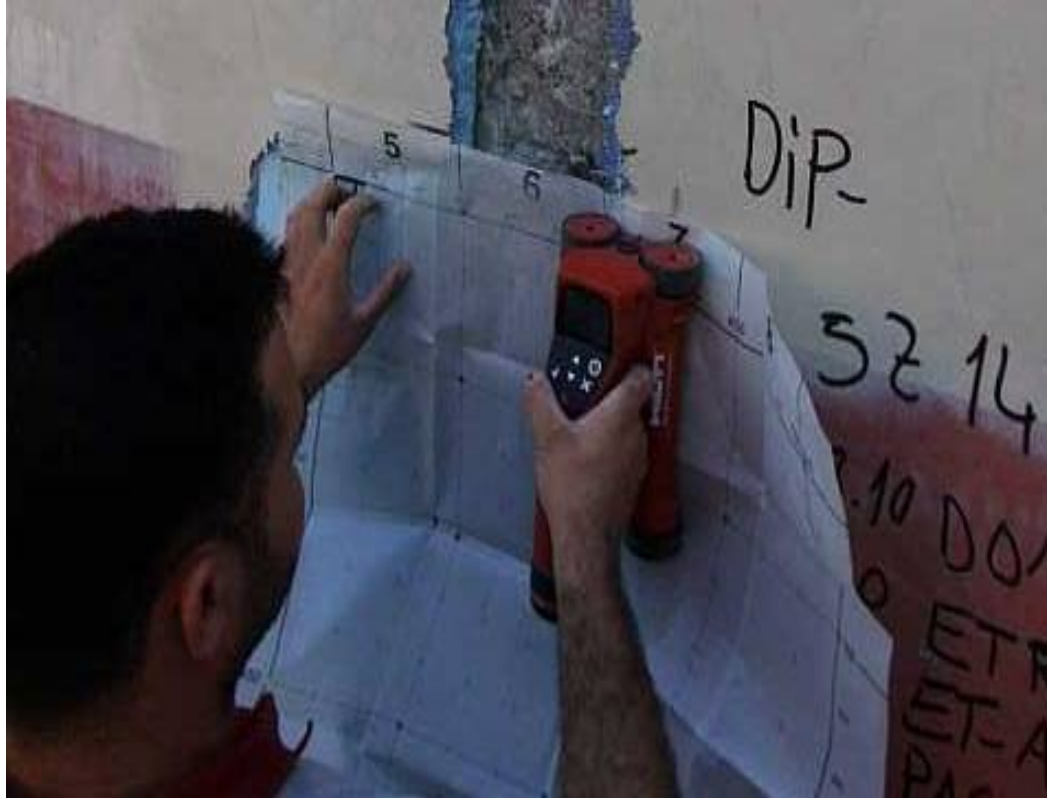
Şekil 3.35 : Tahribatsız yöntem (röntgen taraması) ile donatı tespiti işlemi
