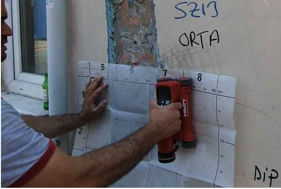
Şekil 3.28 : Tahribatsız yöntem (röntgen taraması) ile donatı tespiti işlemi
