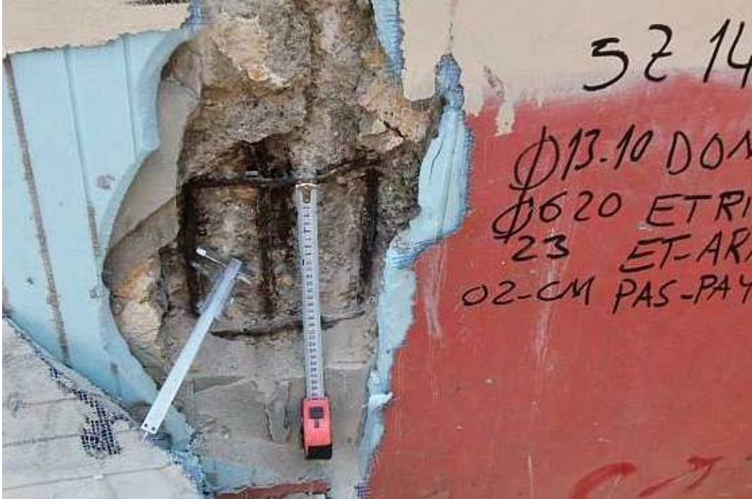
Şekil 3.23 : Tahribatlı yöntem(sıyırma) ile donatı tespiti işlemi
