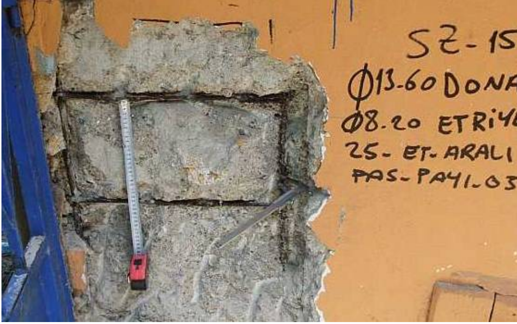
Şekil 3.22 : Tahribatlı yöntem(sıyırma) ile donatı tespiti işlemi
