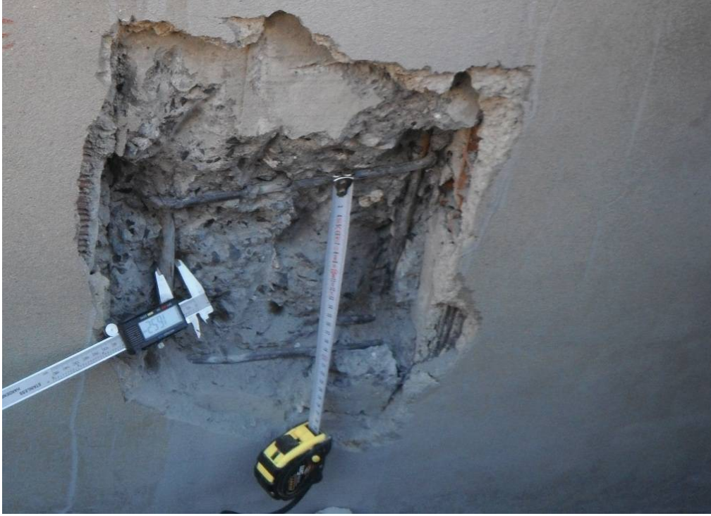
Şekil 3.26 : Tahribatlı yöntem(sıyrma) ile donatı tespiti işlemi
