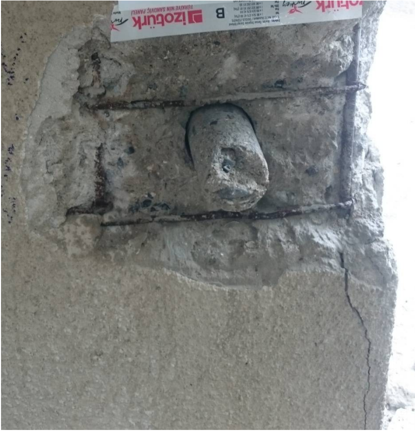
Şekil 3.14 : Karot numune alma işlemi
