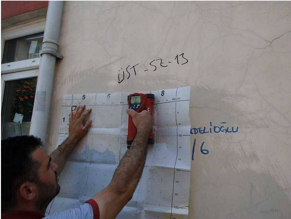
Şekil 3.29 : Tahribatsız yöntem (röntgen taraması) ile donatı tespiti işlemi
