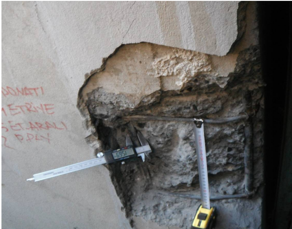
Şekil 3.27 : Tahribatlı yöntem(sıyrma) ile donatı tespiti işlemi
