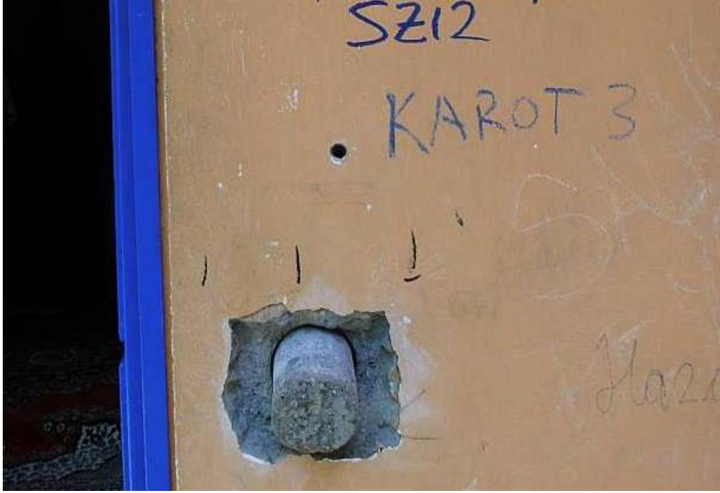
Şekil 3.9 : Karot numune alma işlemi
