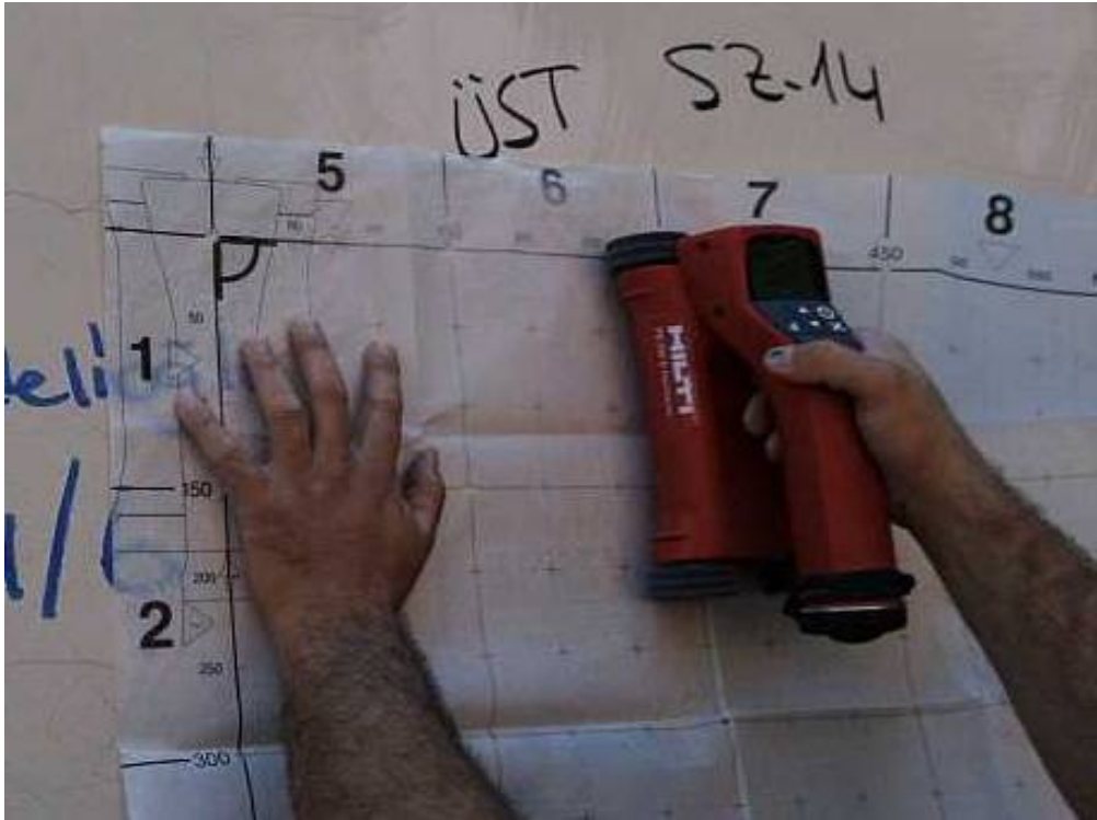
Şekil 3.33 : Tahribatsız yöntem (röntgen taraması) ile donatı tespiti işlemi
