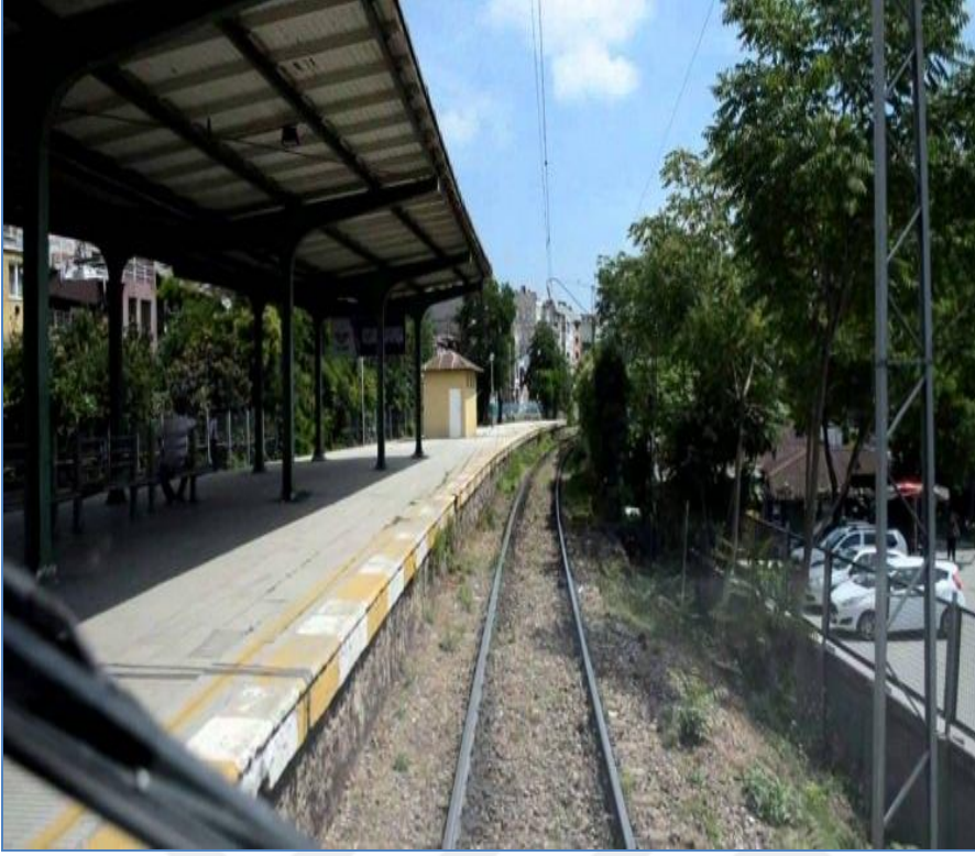
Şekil 4. 4 : Sirkeci-Halkalı Rehabilitasyon Çalışmaları
