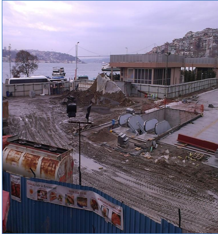
Şekil 4. 7 : Üsküdar-Ümraniye Metrosu İstasyon Çalışmaları
