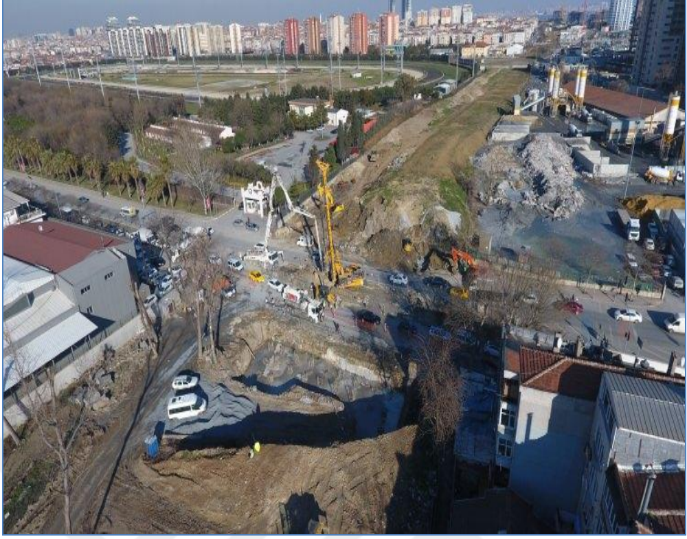
Şekil 4. 2 : Gebze-Halkalı Raylı Sistem Hat Rehabilitasyon Çalışmaları
