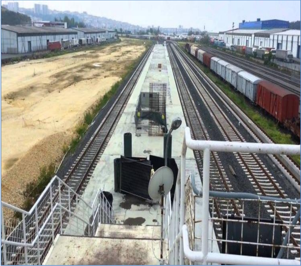
Şekil 4. 3 : Gebze-Halkalı Raylı Sistem Hattı Tamamlanmış Kesimi
