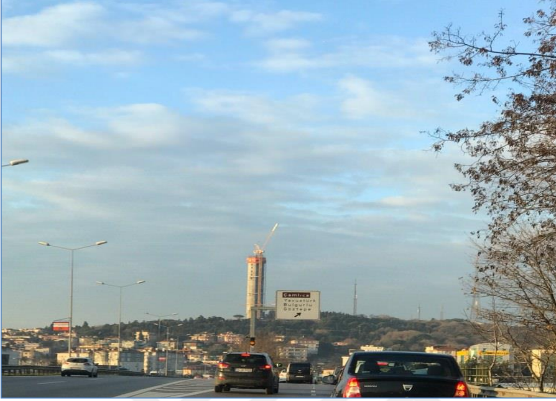
Şekil 2.6: Çamlıca Kulesi İnşa Çalışmaları (Bureau of Statistics of Beijing, 2004: 9)
