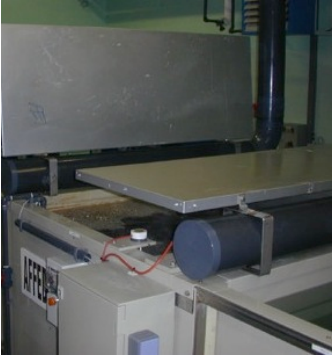
Şekil 7.4: Koruyucu kaplama tankı kapağı
