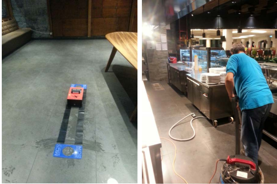
Şekil 5.1: İşletme zeminine antislip malzeme uygulanması
