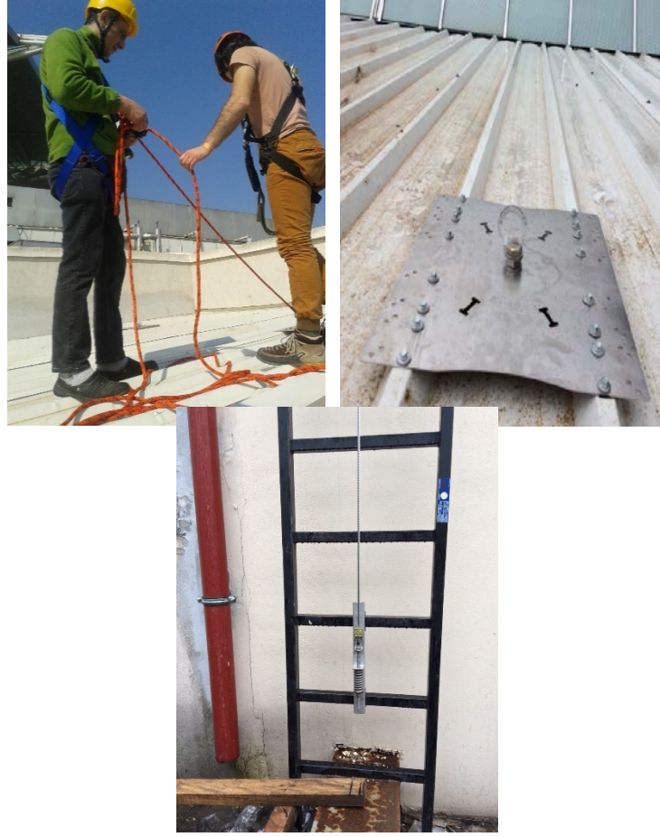
Şekil 5.12: Yüksekte çalışma iyileştirmeleri
