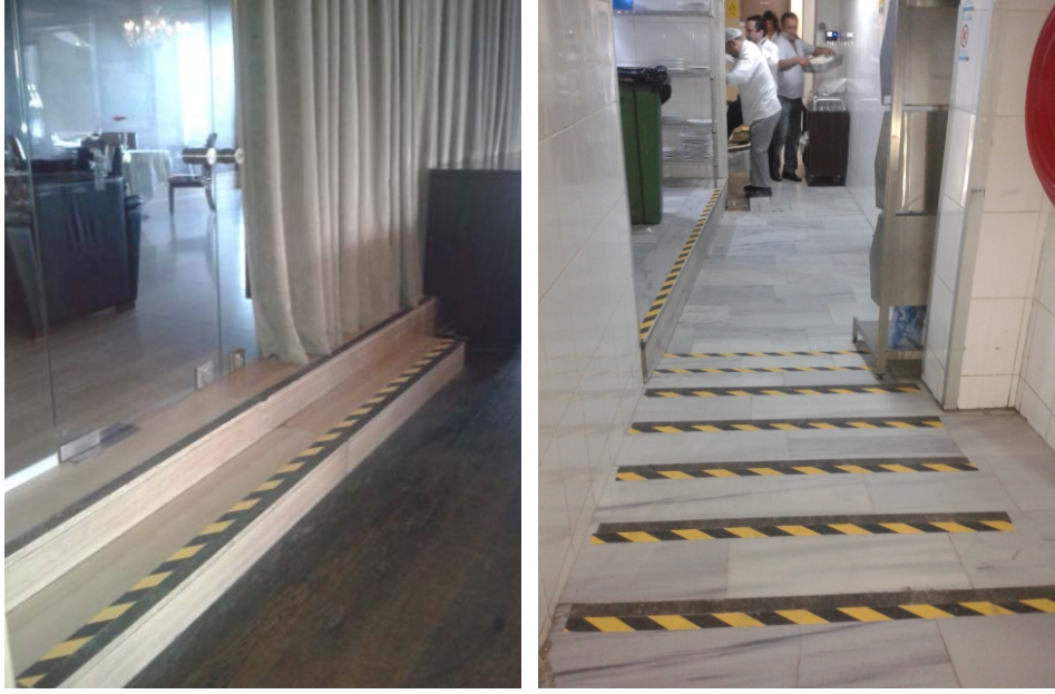
Şekil 5.3: Basamak ve rampalarda kaydırmaz bant uygulaması
