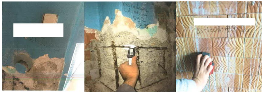
Şekil 33: Yapı-6 Karot alınması, sıyırma ve tarama ölçümü yapılması
