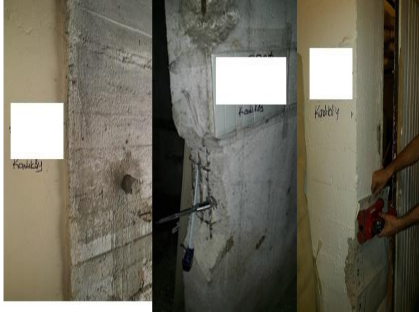
Şekil 39: Yapı-8 Karot alınması, sıyırma ve tarama ölçümü yapılması
