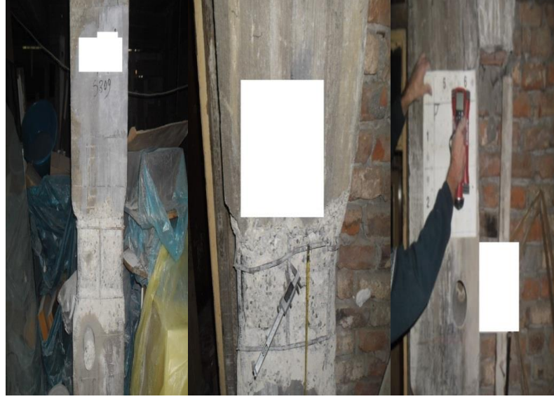
Şekil 18: Yapı-1 Karot alınması, sıyırma ve tarama ölçümü yapılması
