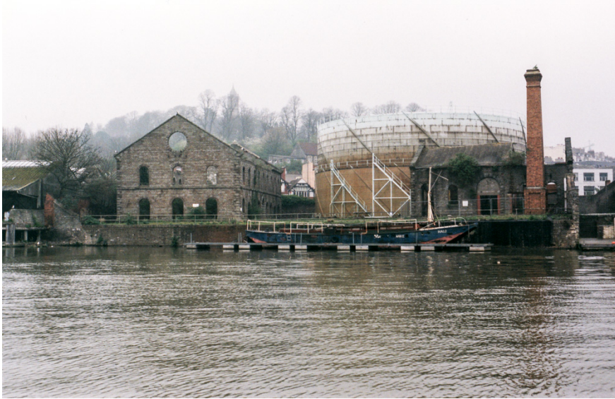
Şekil 5.14. : Watershed bölgesinde bulunan metruk Sanayi binaları (Url-12)
