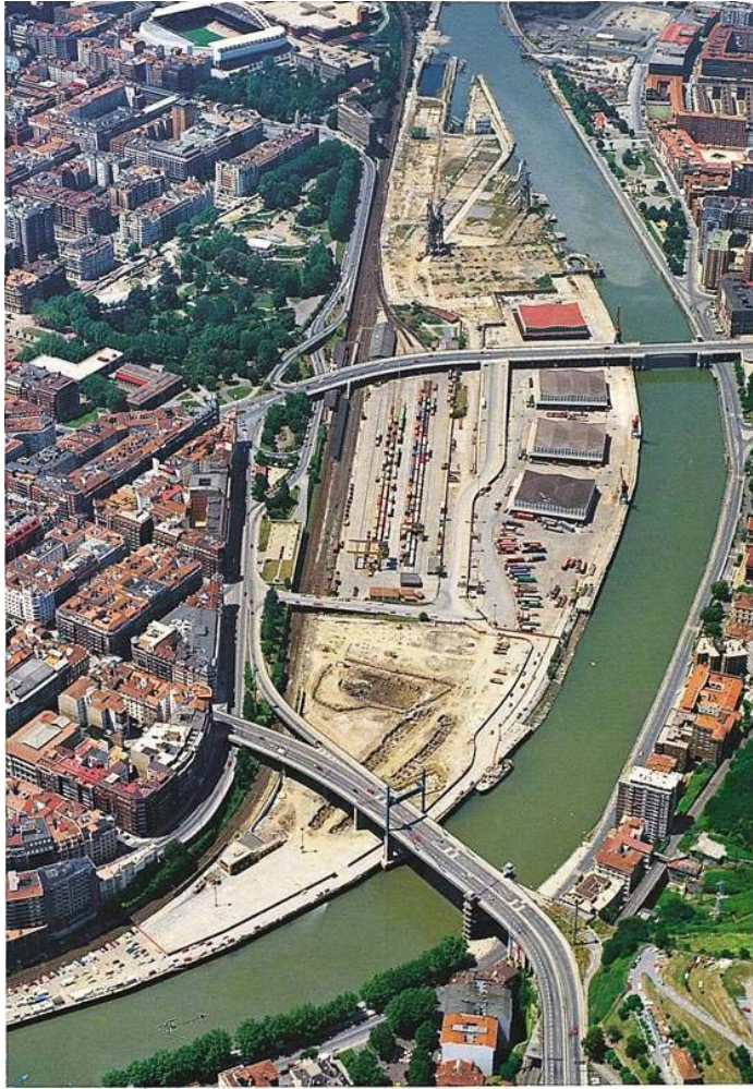
Şekil 5.8. : Abandoibarra bölgesinin Kentsel Yenilemeden önceki durumu, 1996 (Url-8).
