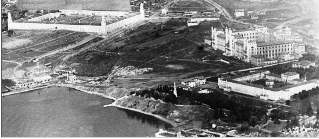
Şekil 5.9: Selimiye Kışlası (Kadıköy Belediyesi, 2019)
