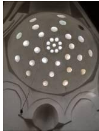
Fotoğraf 6. Eski (Şifa) Hamamı kadınlar sıcaklık kısmı
