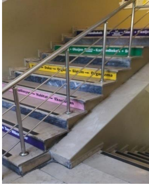
Şekil 3.6: Okullarda bulunan merdivenler
