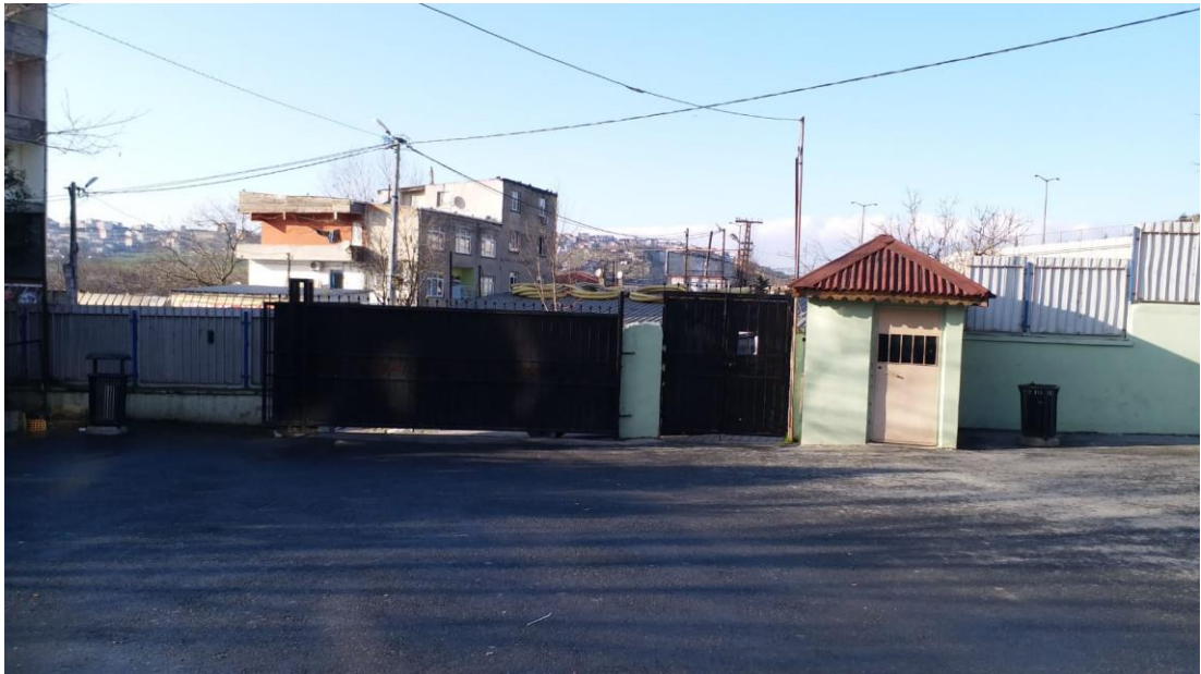
Şekil 3.22: Okulların giriş kapısında bulunan güvenlik görevlisi
