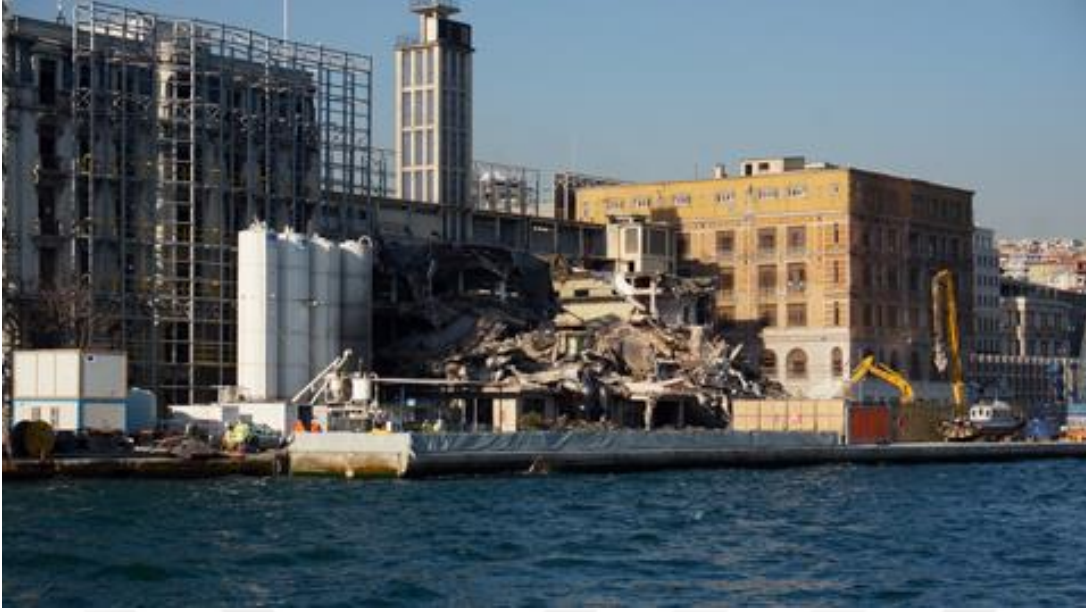
Şekil 3.32: Karaköy Yolcu Salonu (günümüz hali)
