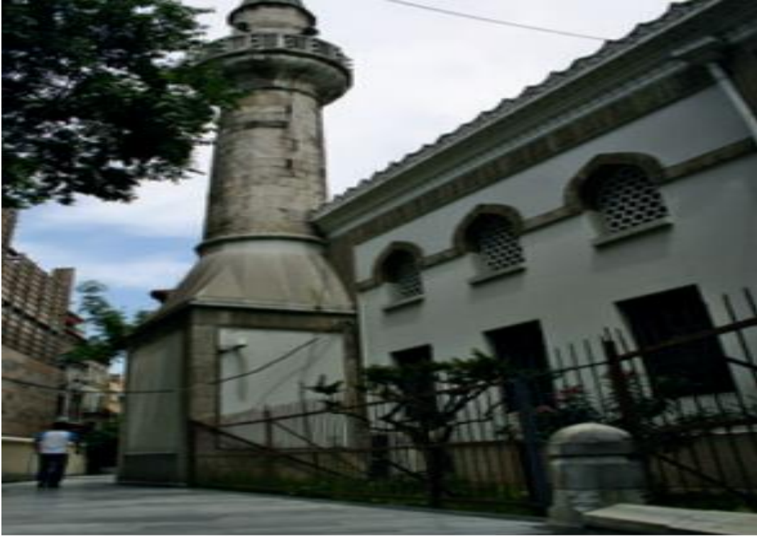
Şekil 3.13: Ağa Camii batı cephesi (günümüz hali)
