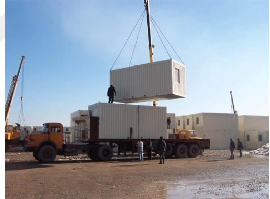
Şekil 3.28 Bir barınağın sahaya (siteye) yerleştirilmesi (URL, 5)
