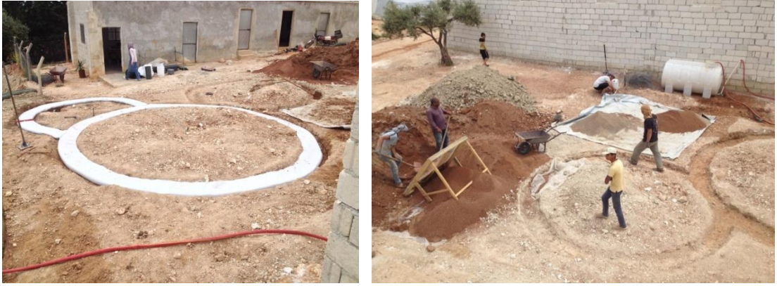
Şekil 3.76 Kibaa eko kubbenin temel alt yapısı (studio, 2015)
