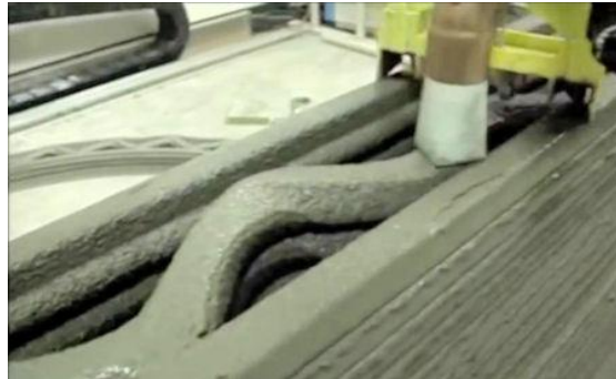
Şekil 4.5 Beton püskürtmeli yazım (Khoshnevis B. , 2004)
