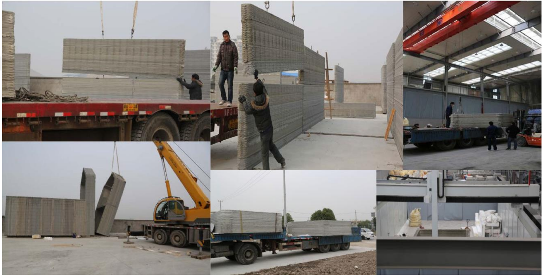
Şekil 4.10 Yingchuang yazıcı ile 3D Ev yapımı (URL, 4)
