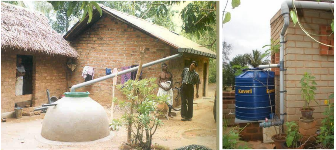
Şekil 3.67 Çamur toprak binalarda yağmur suyunun toplanması (URL, 5)
