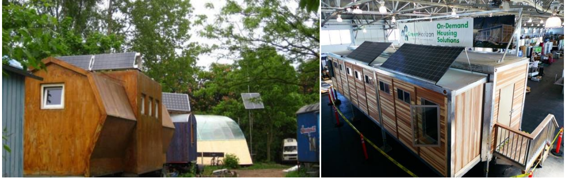
Şekil 3.34 Prefabrike barınaklarda, güneş enerjisi panellerinin kullanılması (URL, 3)
