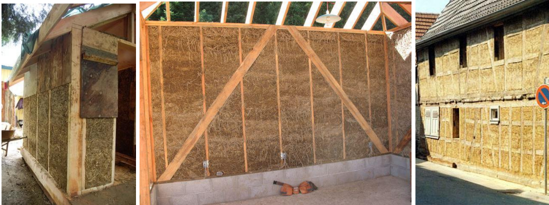
Şekil 3.62 Çamurun kalıp içinde şekillendirilmesiyle bina yapımı (CSILLIK, 2012)
