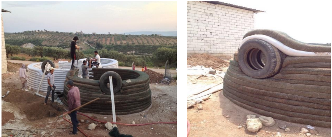
Şekil 3.78 Kibaa eko kubbede pencerelerin yapılması (studio, 2015)
