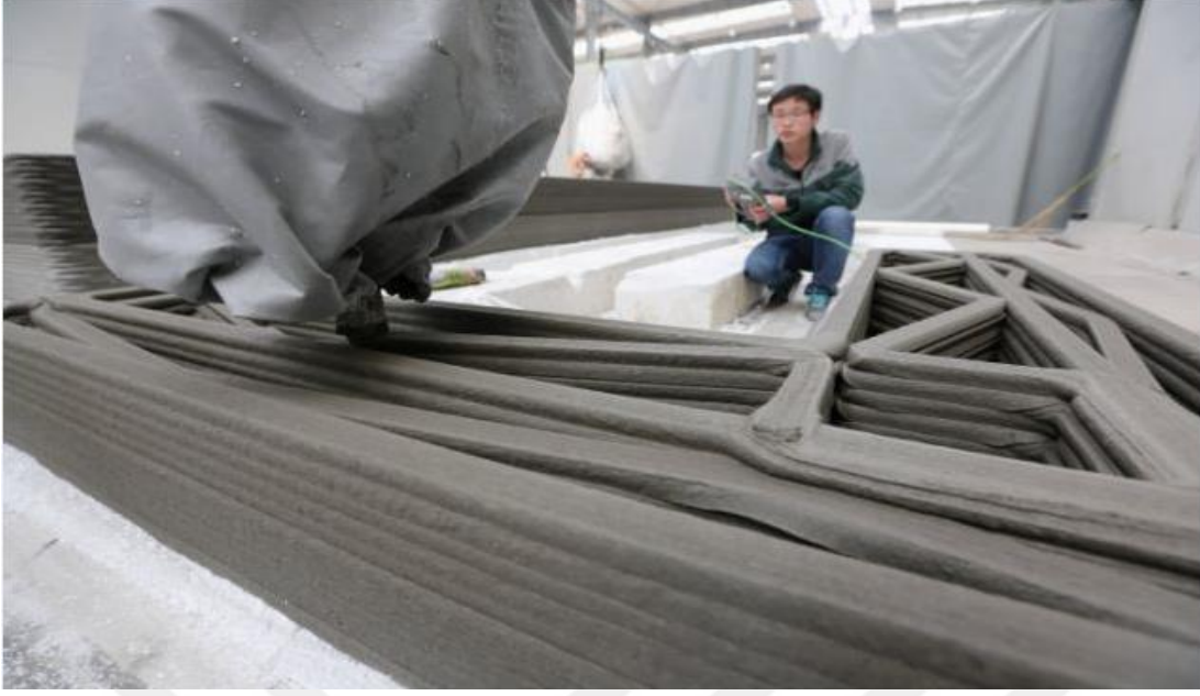
Şekil 4.11 Yingchuang yazıcı ile beton dökümü (URL, 4)
