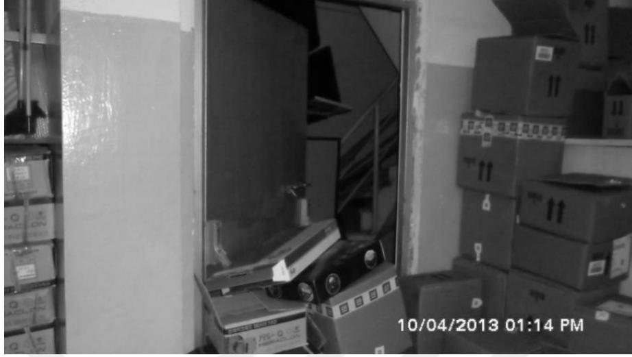
Şekil 2.11: Düzenleme yapılmadan önce bir yangın çıkışı(Kaporta Bölümünden)
