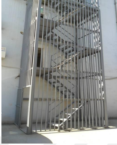
Şekil 3.6: Katlı Otomotiv tamir servisinde dış yangın merdivenleri
