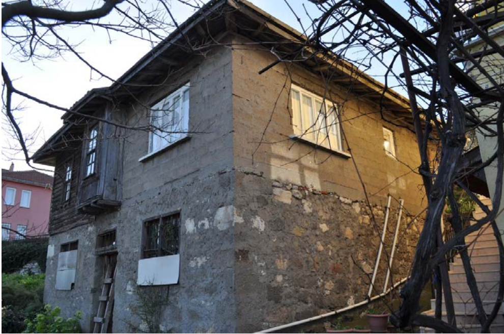
Şekil 4. 34: Deprem sonrası onarımlı tuğla biriket işlenen duvar
