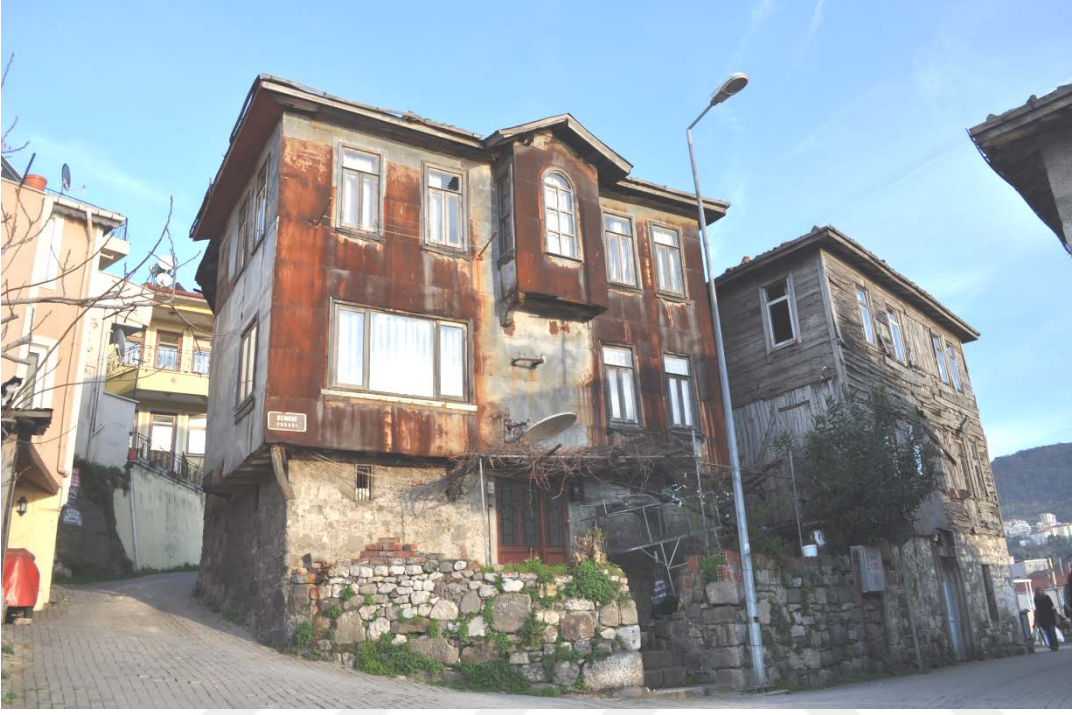
Şekil.4.100: Giriş cephesi görünümü
