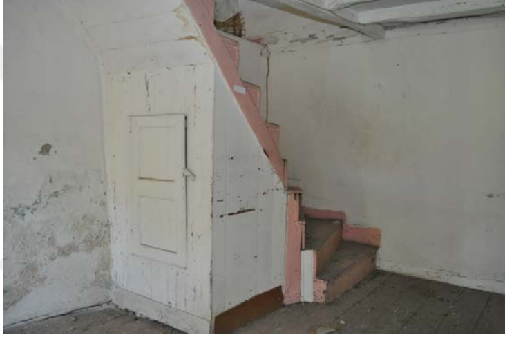
Şekil 4. 44: Merdivenin birinci kat sofasından görünümü ve dolap olarak değerlendirilen merdiven altı
