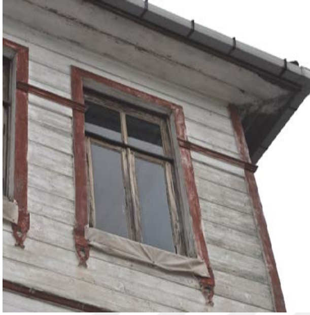
Şekil 4. 73: Pencere pervazı süslemesi ve pencerenin üst bölümünden yatay şekilde geçen kuşluk detayı
