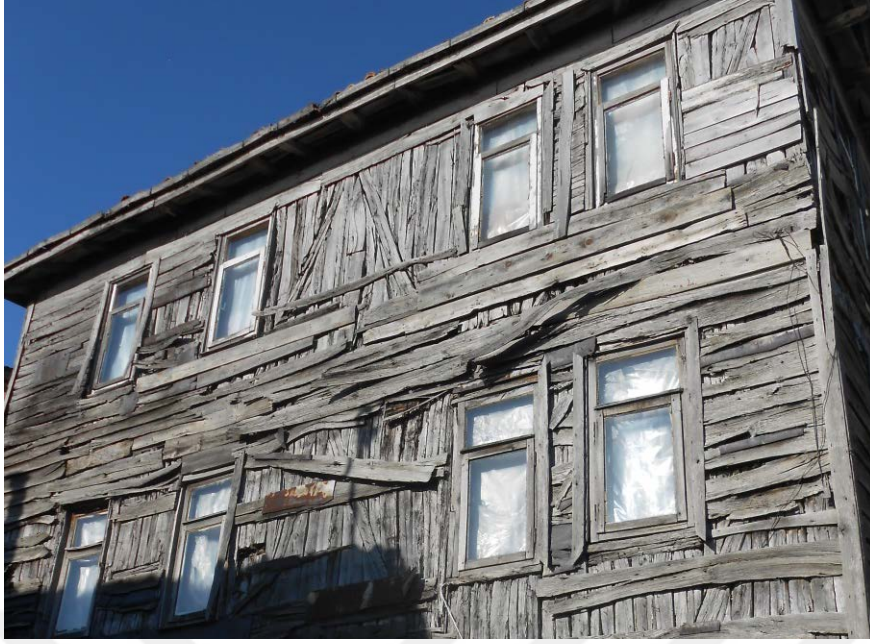
Şekil 3. 32 Ahşap karkas arası ahşap dolgu tekniği
