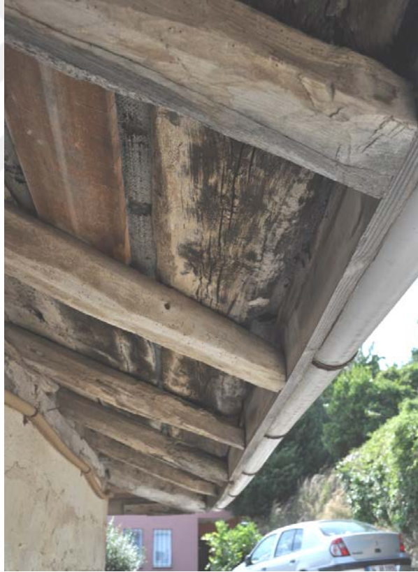
Şekil 3.39 Bölgedeki evlerden bir çatının saçak altı
