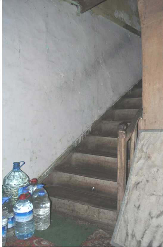
Şekil 4. 125: Kulluktan birinci kata çıkış merdivenleri
