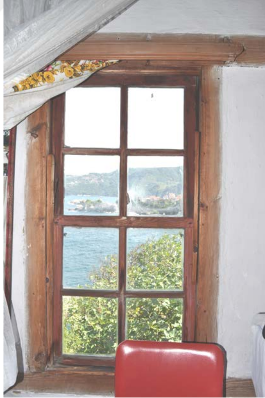
Şekil 4. 31: Geleneksel giyotin pencere ve pencereden görünen deniz manzarası
