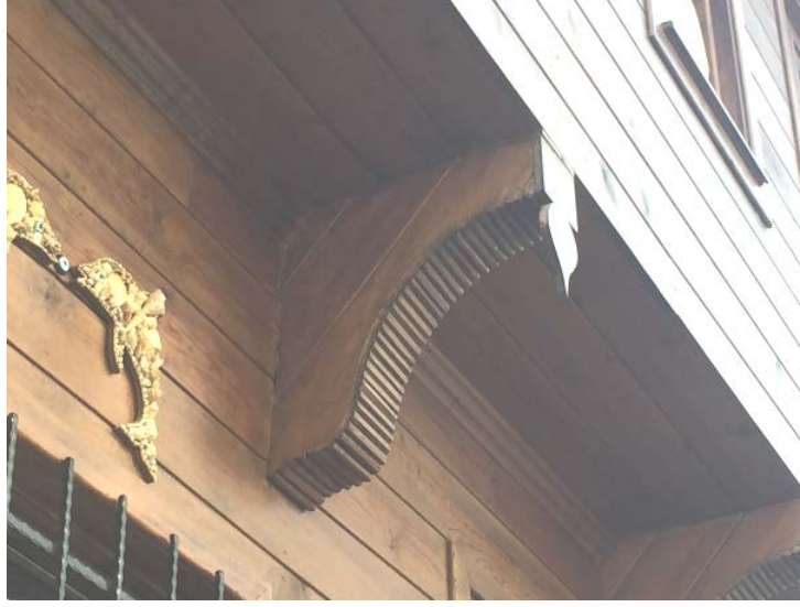
Şekil 3.48: Kum oteldeki çıkma altı payanda süslemesi
