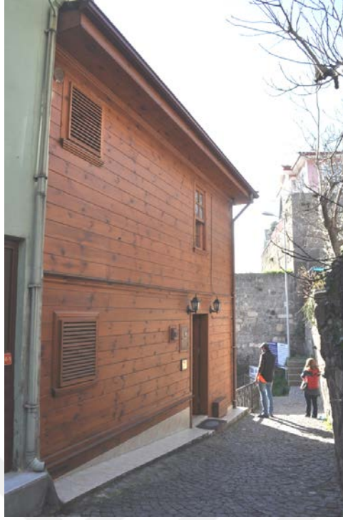
Şekil 4. 86: Evin giriş kapısının olduğu arka cephe görünümü
