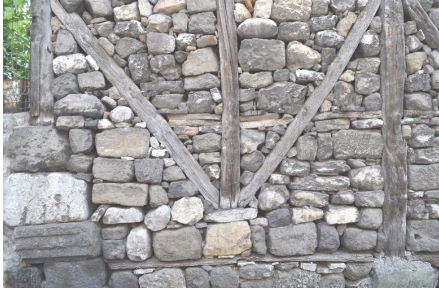
Şekil 3. 37 Ahşap karkas arası taş dolgu
