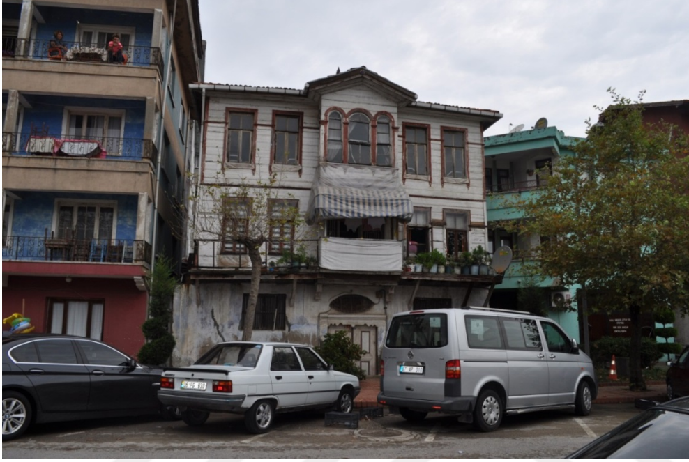
Şekil 4. 63: Giriş cephesi görünümü
