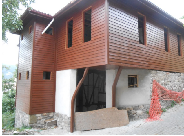
Şekil 4.2: Evin giriş cephesinden görünümü
