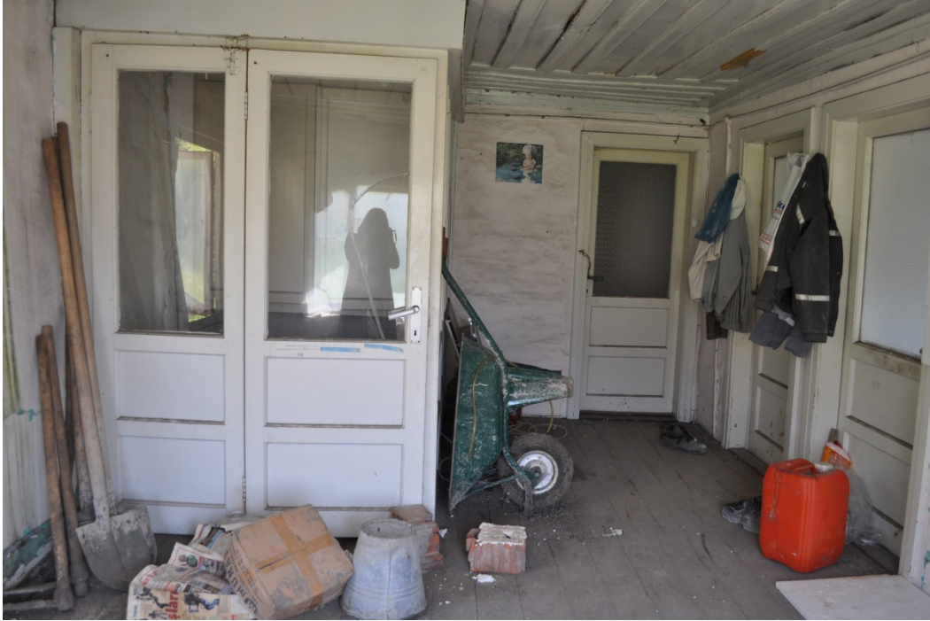
Şekil 4. 50: İkinci kat sofasından merdiveni kapatan cam ve ahşap panel duvar, karşıda abdestlik kapısı ve sağda oda kapıları
