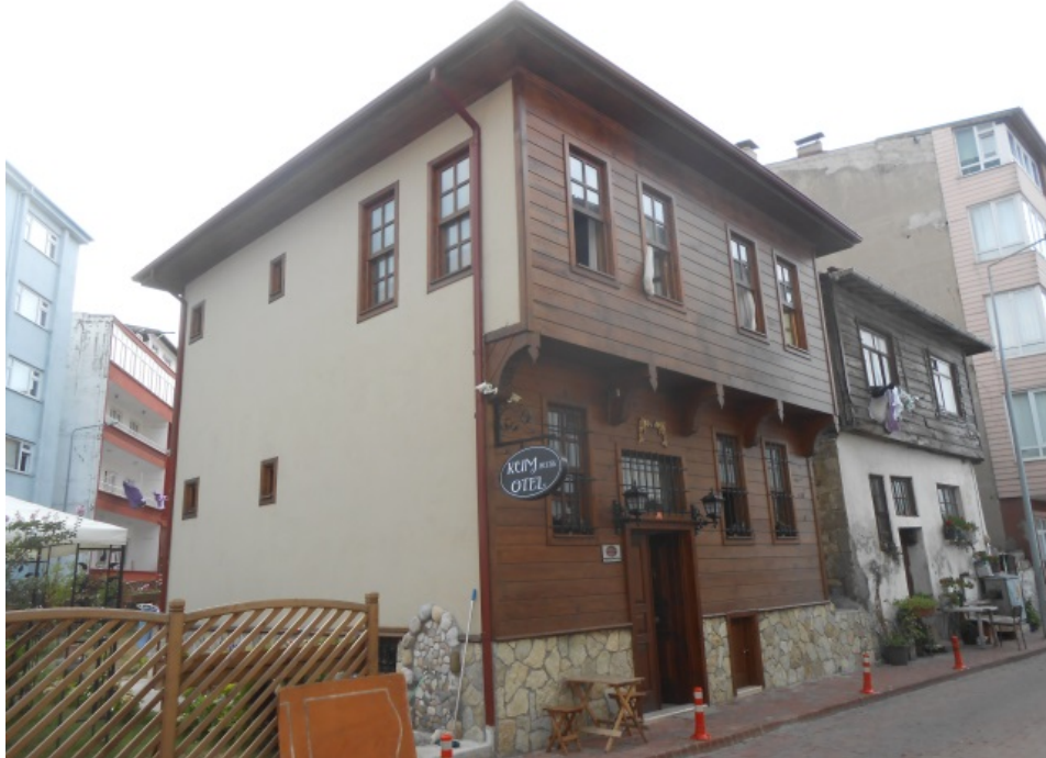
Şekil 4.12: Giriş cephesi görünümü
