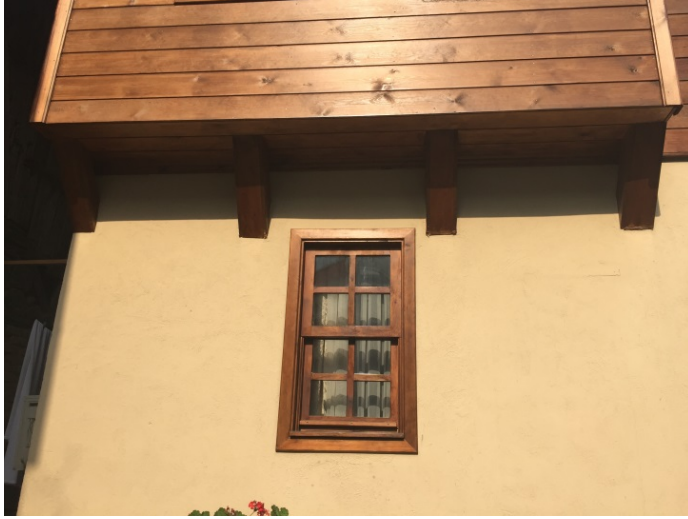
Şekil 4. 23: Arka cephedeki çıkmanın payandaları
