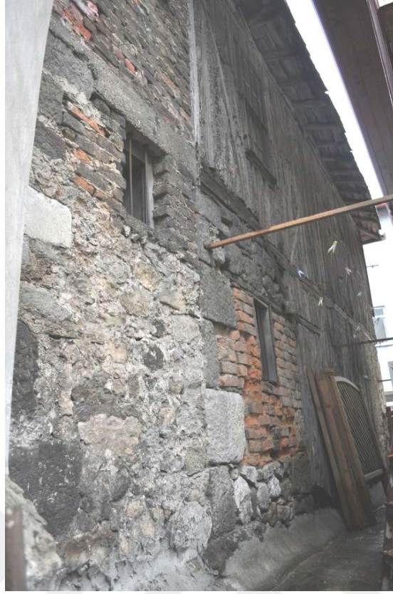
Şekil 4. 132: Evin yarısı tuğla dolgu ile yapılmış sol yan cephesi
