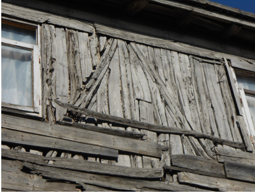
Şekil 4. 60: Evin ahşap dolgu duvarları
