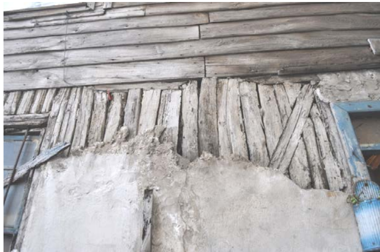
Şekil 4. 129: Ahşap karkas arası ahşap dolgu tekniği ve üzerinden dökülmüş sıvası
