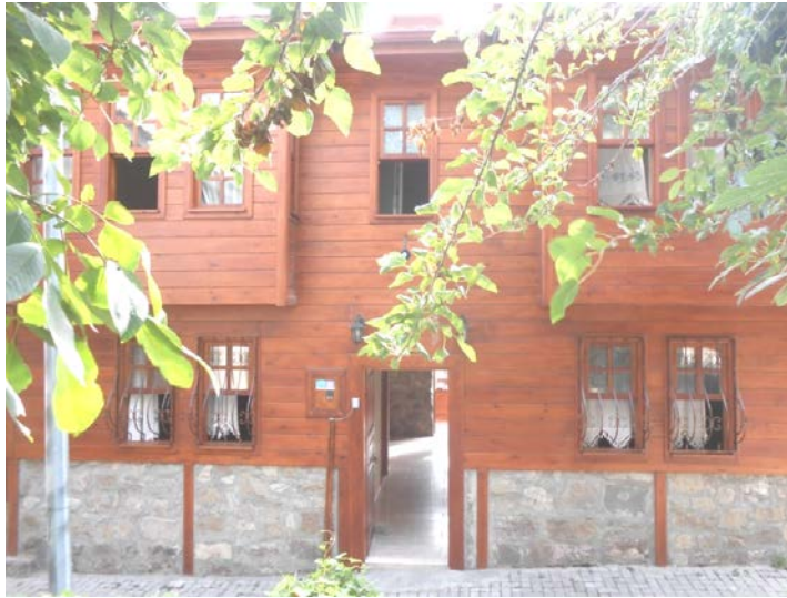
Şekil 4. 97: Evin ön cephesi ve eve girişi sağlayan kulluk kapısı
