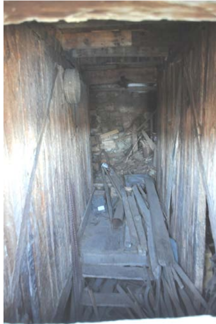
Şekil 4. 27: Kulluğun giriş holü
