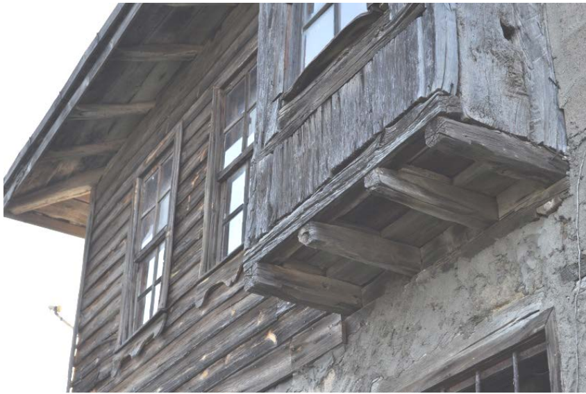
Şekil 3.44: Konsol kirişli çıkma örneği
