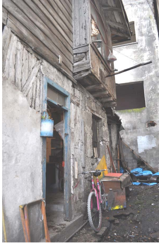
Şekil 4. 133: Sağ yan cephedeki kullukta ayrı girişi olan odanın kapısı ve birinci katın kapalı çıkması
