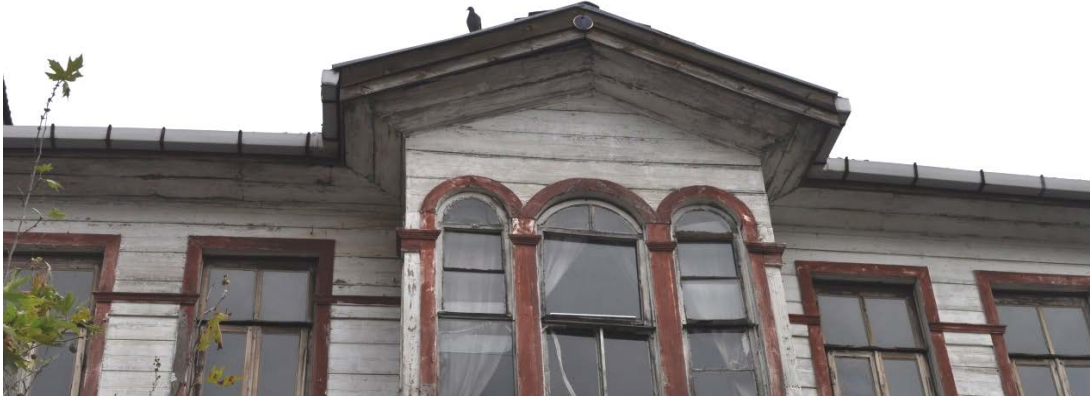
Şekil 3.47: Pencerenin üst kısmına yakın olan bölümde bulunan kuşluk
