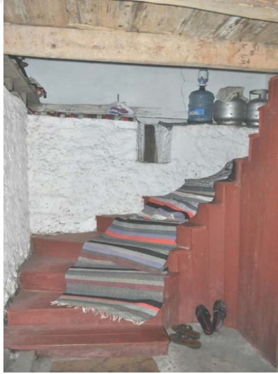
Şekil 4. 105 Kulluktan birinci kata çıkan merdivenler ve merdiven arkasında oluşmuş pasakdibi
