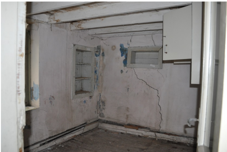
Şekil 4. 48: Arka cepheye bakan, abdestlik ve ocakla bağlantılı olan içer (oda). Duvarda ahşap sergenli (raf) nişler
