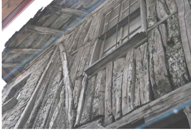
Şekil 4. 130: Evin ahşap karkas arası ahşap dolgu tekniği ile yapılmış duvarları
