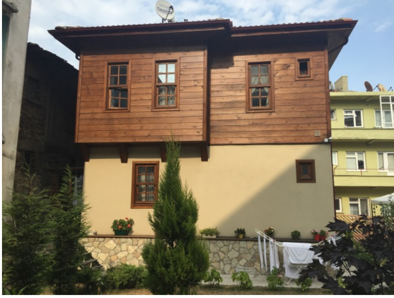
Şekil 4.13: Arka cephe görünümü
