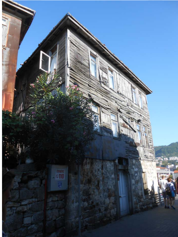
Şekil 4.55: Sertellerin evi sokak üzerindeki kulluk kapısı
