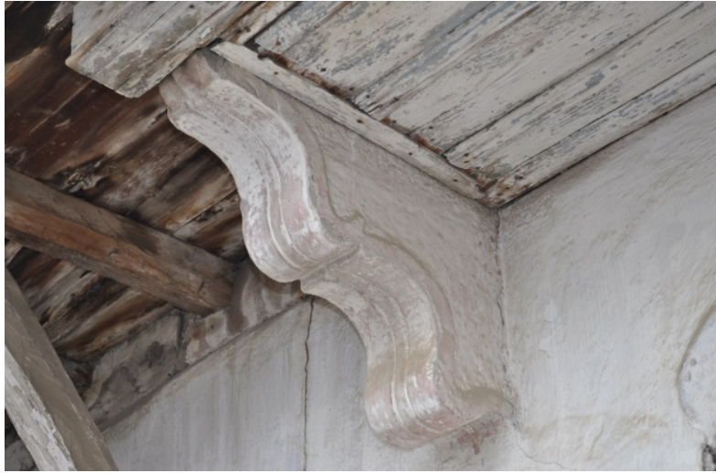
Şekil 4. 72: Balkon altı payandasının süslemesi
