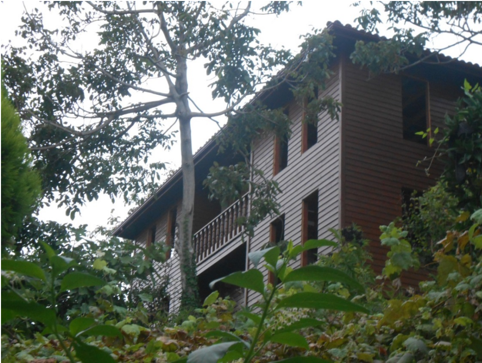
Şekil 4.10: Arka cephedeki balkon görünümü
