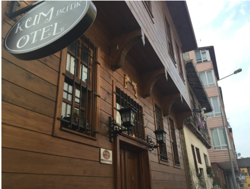
Şekil 4. 22: Konsol çıkmanın altındaki eliböğründeler
