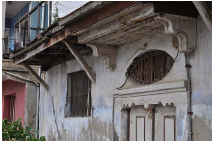
Şekil 4. 69: Balkon altındaki ve balkonun yana uzantısını taşıyan payandalar
