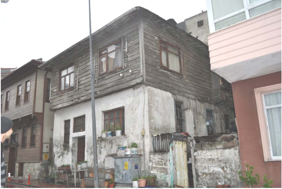
Şekil 4. 121: Postacı Mehmetlerin evi yol cehpesi görünümü
