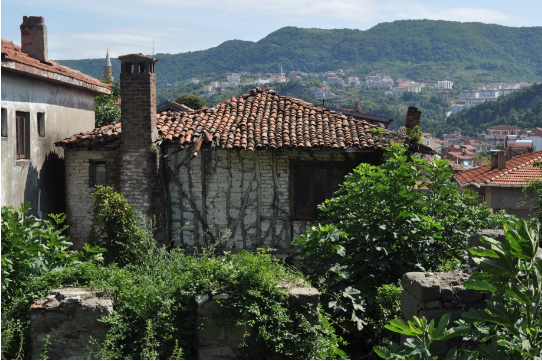
Şekil 4. 53: Yan cephe görünen ahşap karkas arası taş ve tuğla dolgu ve solunda dışa taşkın ocak bacası
