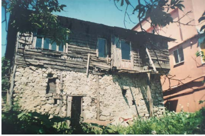
Şekil 4. 95: Restore öncesi evin arka cephesi (Zor, 2015)
