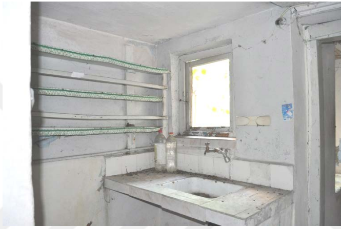
Şekil 3. 18: Büyükdalıların evindeki abdestlik tezgahı ve yan duvar üzerindeki sergenler (raflar)
