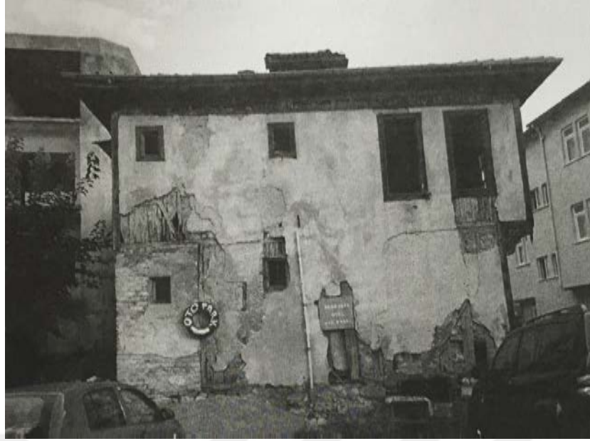
Şekil 4. 15: Restore edilmeden önce sol yan cephe görünümü (belediye arşivi)
