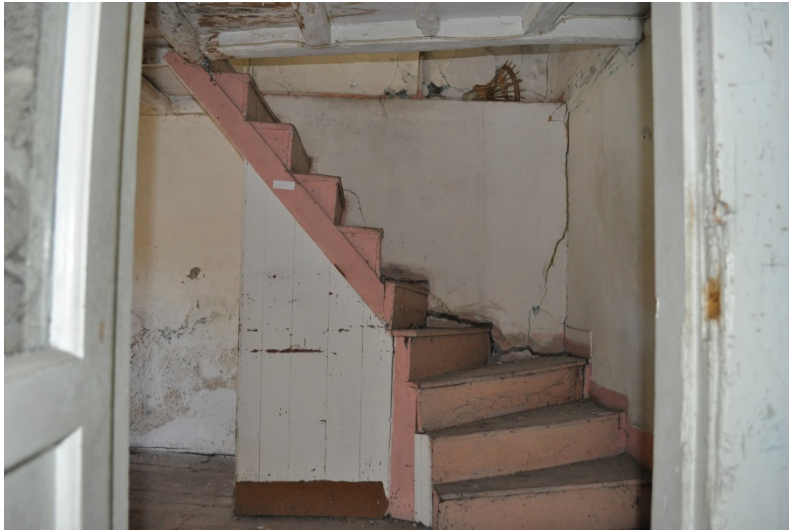
Şekil 4. 45: Arkadaki oda kapısından merdiven görünümü ve taş duvarda oluşan pasakdibi
