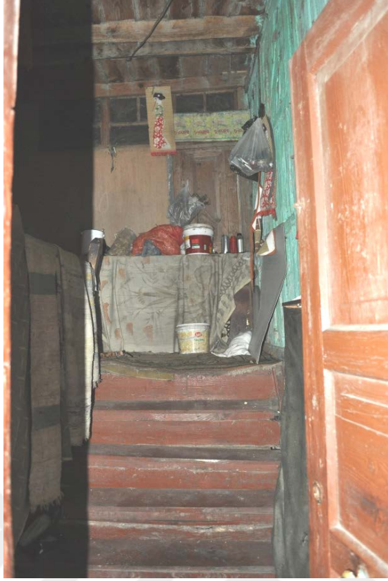
Şekil 4. 124: Evin giriş kapısı ve kulluğa çıkış merdivenleri
