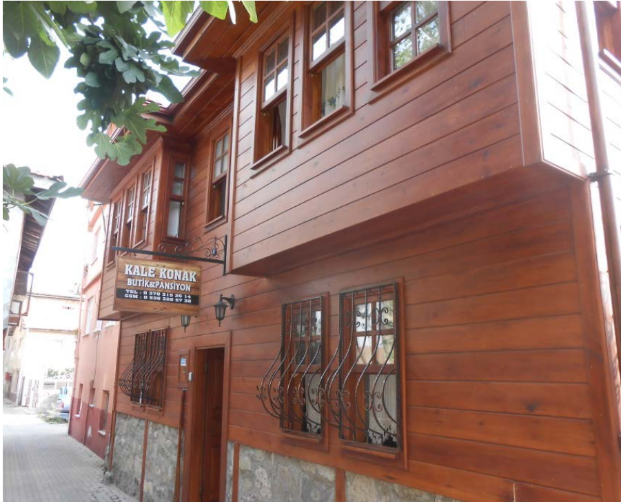
Şekil 4. 87: Giriş cephesi görünümü
