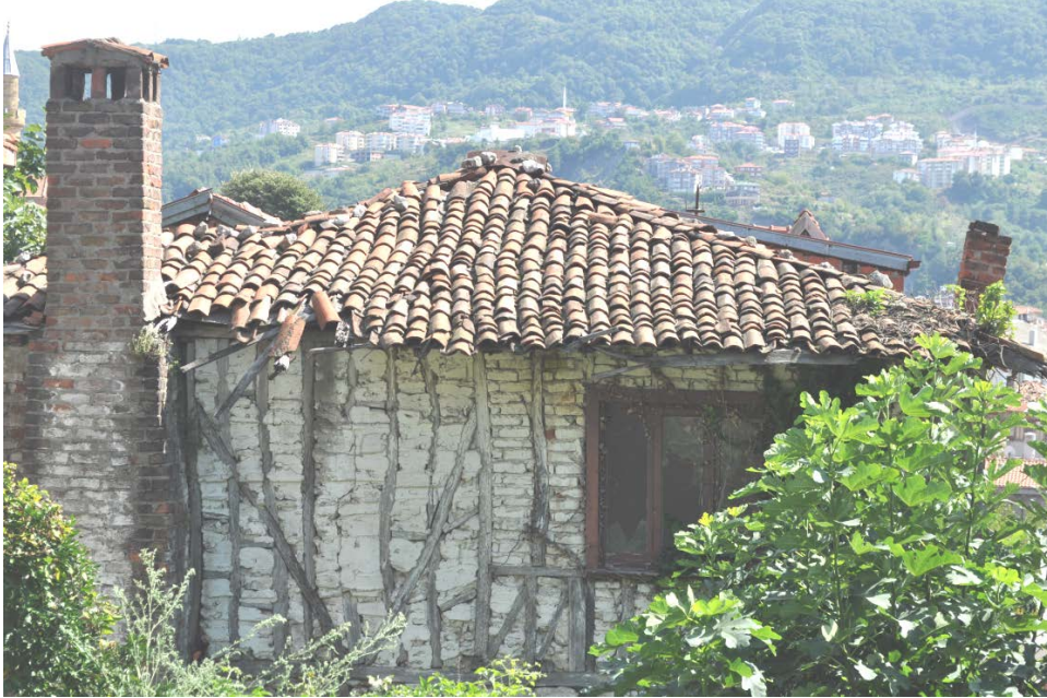
Şekil 3. 36 Ahşap karkas arası taş ve tuğla dolgu tekniği
