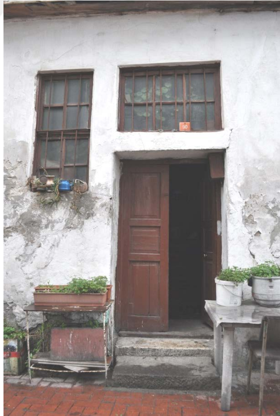
Şekil 4. 135: Eve girişi sağlayan kulluk kapısı
