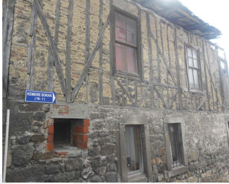
Şekil 3. 33: Ahşap karkas arası kerpiç dolgu tekniği
