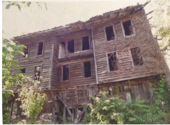
Şekil 4.4: Evin restore öncesi arka cephe görünümü (Amasra belediye arşivi)
