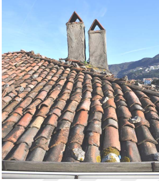
Şekil 3. 38 Geleneksel alaturka kiremit çatı örtüsü örneği
