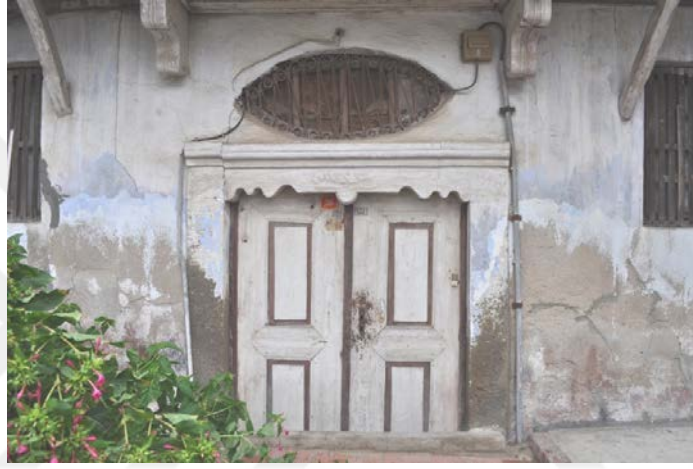
Şekil 3. 6: Kulluk girişindeki çift kanatlı sağır kapı ve üzerinde penceresi
