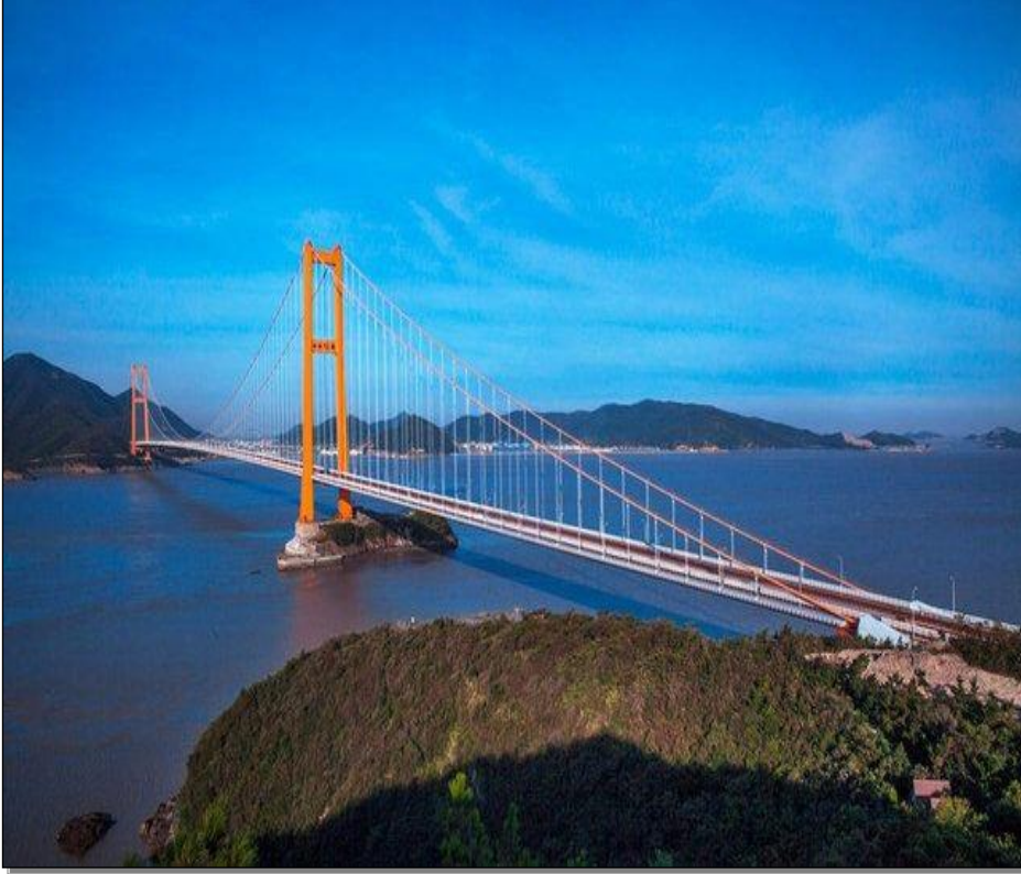
Şekil 4.6: Güney Kore'den Bir Köprü Görünümü (Ho vd, 2002: 143)
