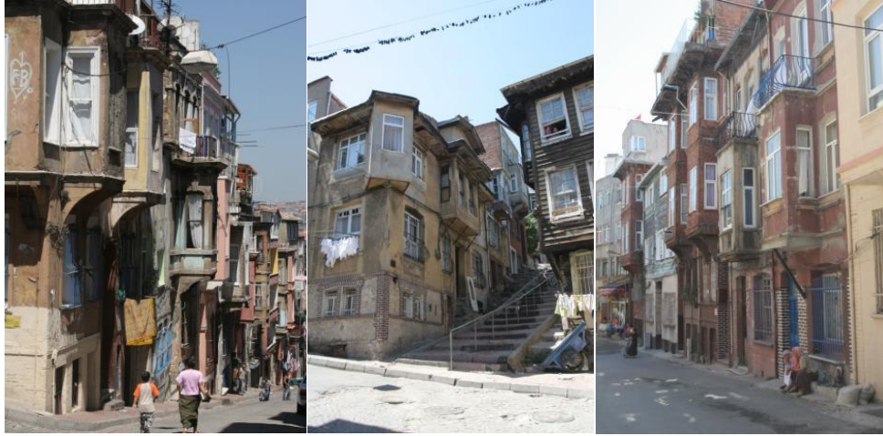
Şekil 45. Fener-Balat Bölgesi yapı örnekleri
