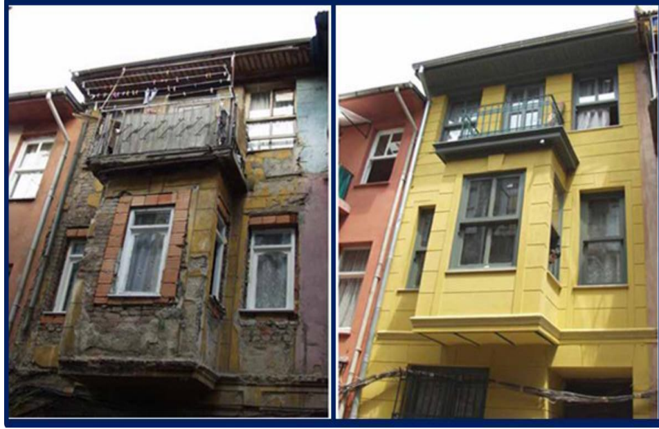
Şekil 39. Fener ve Balat Konut Yenileme (Önce ve Sonrası)
