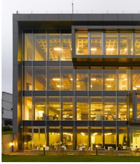
Şekil 108. Cephedeki açılan pencereler binanın doğal havalandırılmasını sağlar
