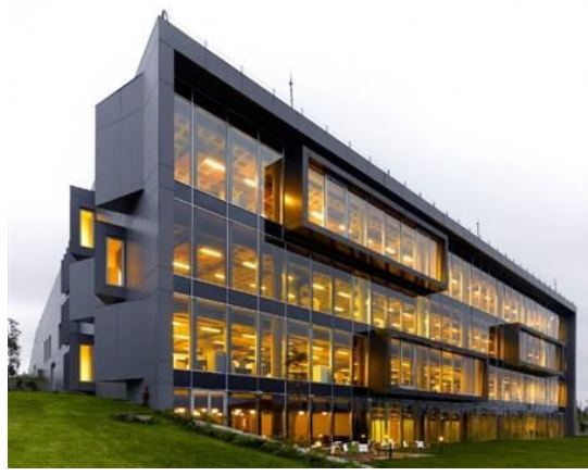
Şekil 117. Turkcell kampüsü binasının dış sığınak alanları
