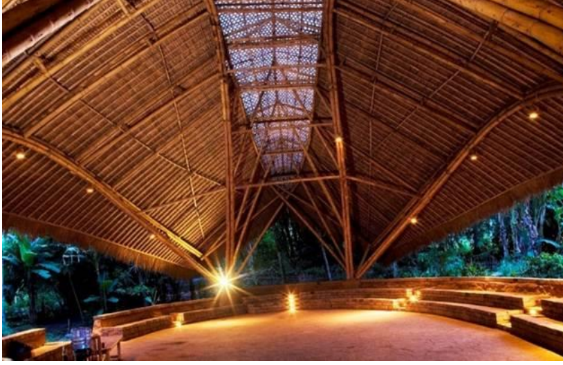
Şekil 23. Yeşil okulun içinden görünüm
