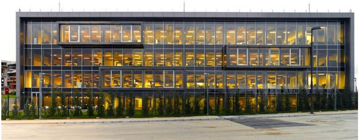
Şekil 105. Turkcell AR-GE binasının komple cam ön cephesi
