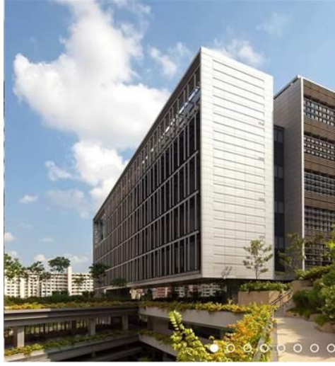
Şekil 7. Hastane binasının ön cephesinden bir görüntü
