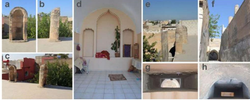
Şekil 43 Şanlıurfa’da bulunan bir konağın (a) kuzeyden ve (b) batıdan rüzgâr alan rüzgâr yakalayıcılarının (c ve e) teras çatıdan ve (f) sokaktan görüntüleri ile eyvan duvarındaki (d) nişlerin üzerinde bulunan (h ve g) rüzgâr çıkışına bakış (Melikoğlu & Bekleyen, 2021).
