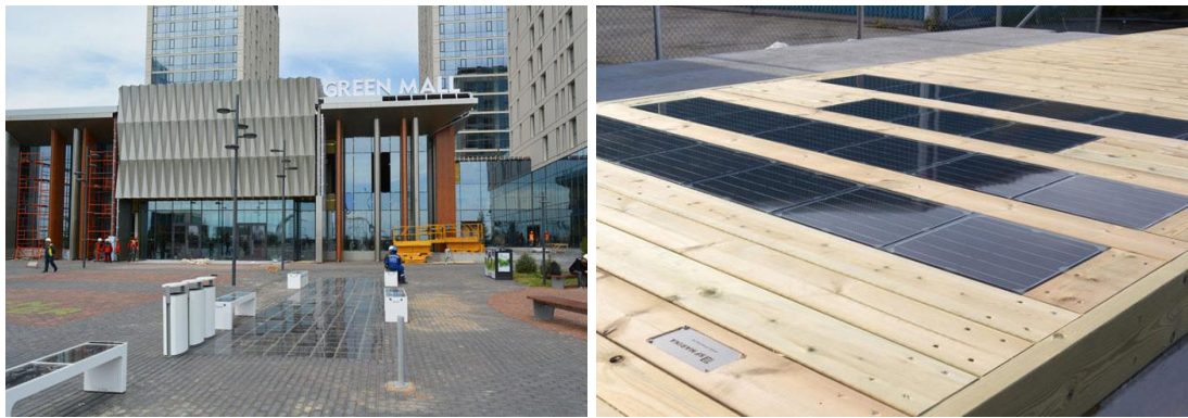
Şekil 31. Yaya Yürüyüş Yolu. Green Quarter Alışveriş Merkezinin Girişine Yakın Olan, Yaklaşık 80 m 2 Genişliğindeki Yürüyüş Yolunda Üretilen Enerji 11.7 kilovata Ulaşıyor. Buradan Elde Edilen Elektrik Alışveriş Merkezinde de Kullanılıyor.
