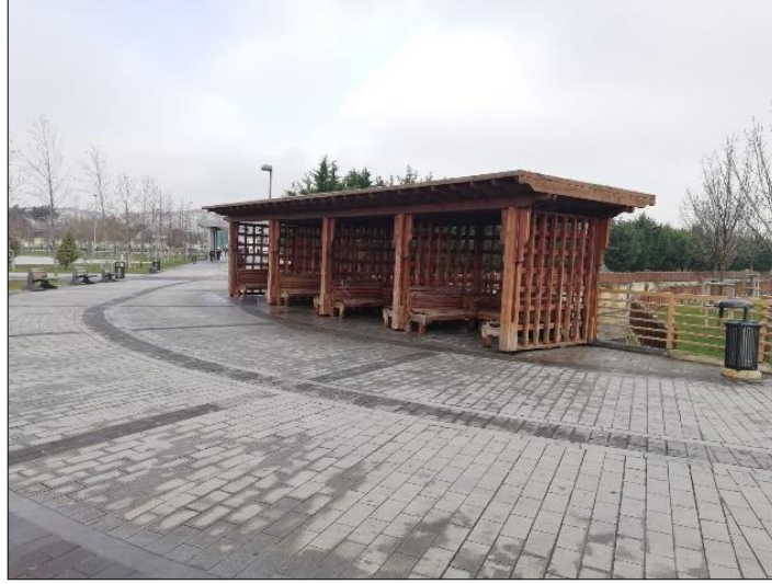
Şekil 4.41 Birinci bölgede üst örtü elemanı-2 (Şekil 4.3:Foto-37)
