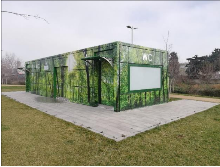
Şekil 4.58 İkinci bölge tuvaletler (Şekil 4.43:Foto-8)
