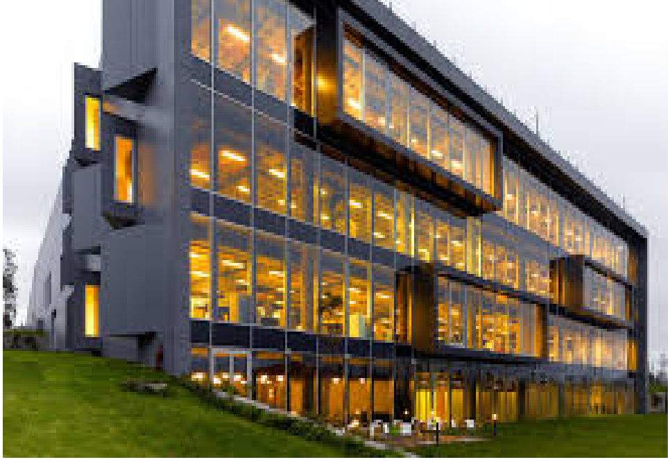
Şekil 4.8: Türkcell Arge Binası
