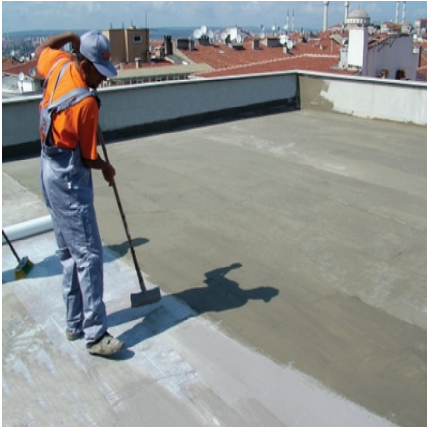
Şekil 3.6: Su Yalıtımı Yapılmadan Önceki Yüzey Hazırlığı
