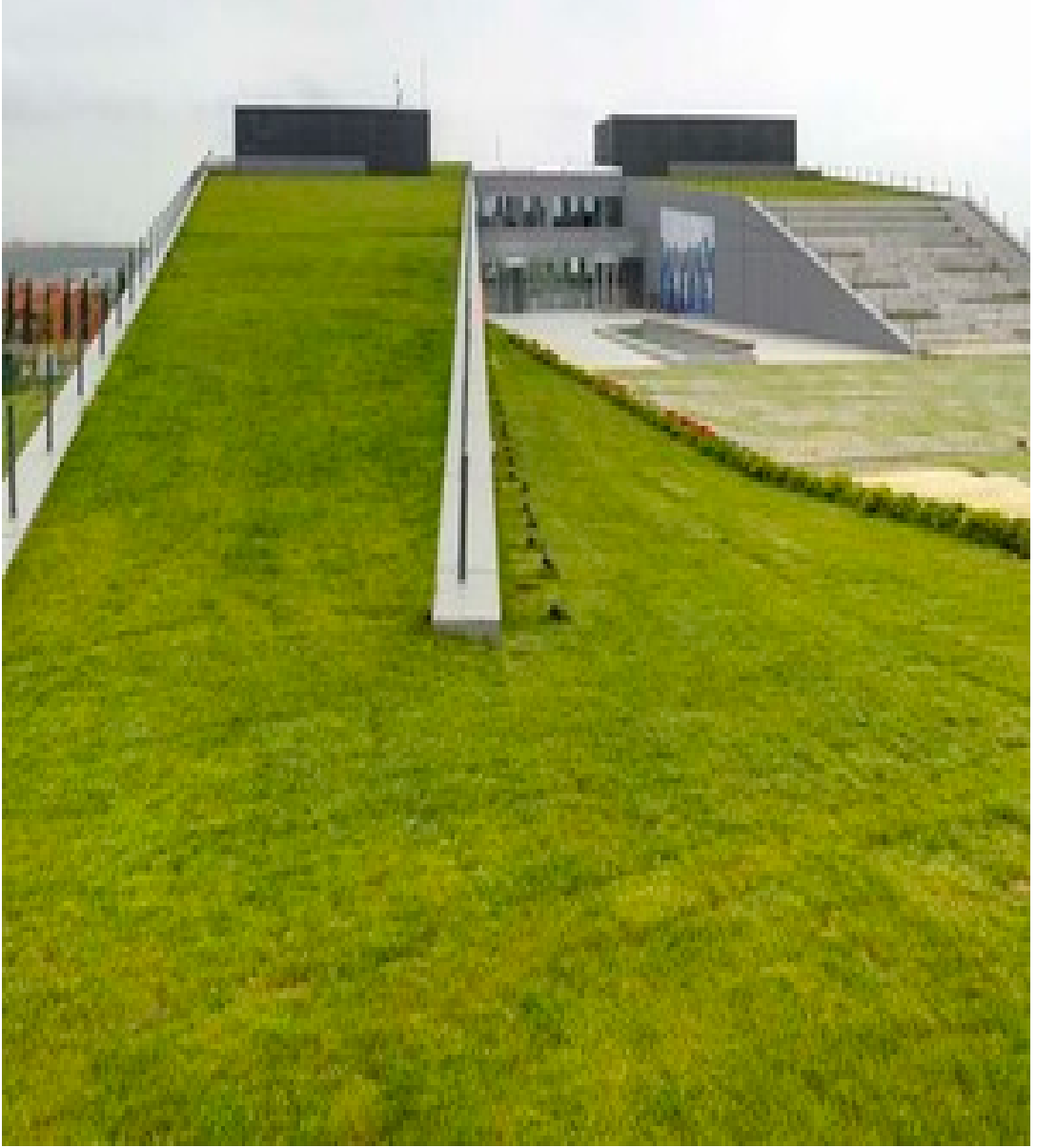
Şekil 4.9: Türkcell Arge Binası Çatısı
