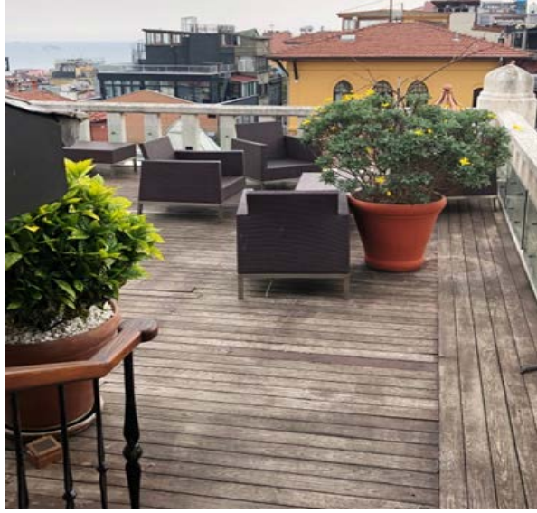
Şekil 5.89: Four Seasons Otel Teras Yer Döşemesi
