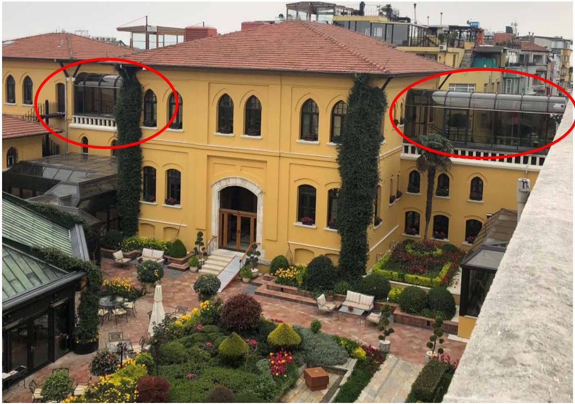
Şekil 5.75: Four Seasons Otel Tüp Geçit Görünümü
