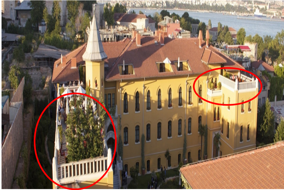
Şekil 5.10: Four Seasons Otel Teras Görünüşü
