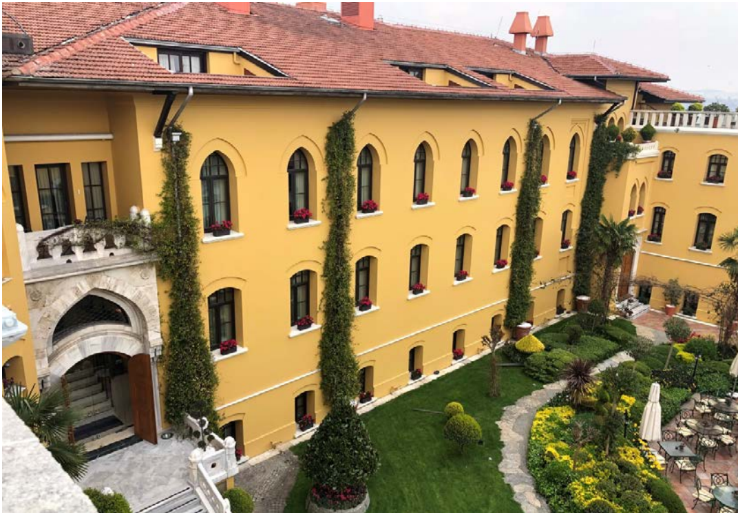
Şekil 5.11: Four Seasons Otel Cephe Pencere Düzeni
