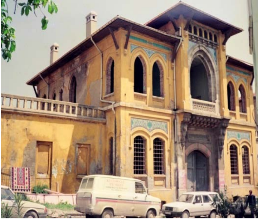
Şekil 5.3: Four Seasons Otel Dönüşüm Aşaması
