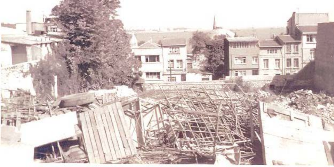
Şekil 4.2: Parsel Temizleme Çalışmaları
