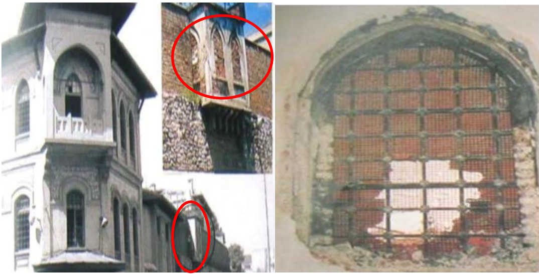
Şekil 4.7: Gözetleme Kulesinin Örülmüş Pencere ve Kapıları
