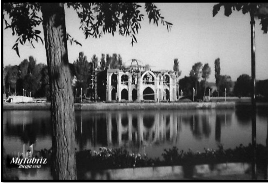
Şekil 6.7: Elgöli köşkün 1945'te inşa edilen hali (Url-12)
