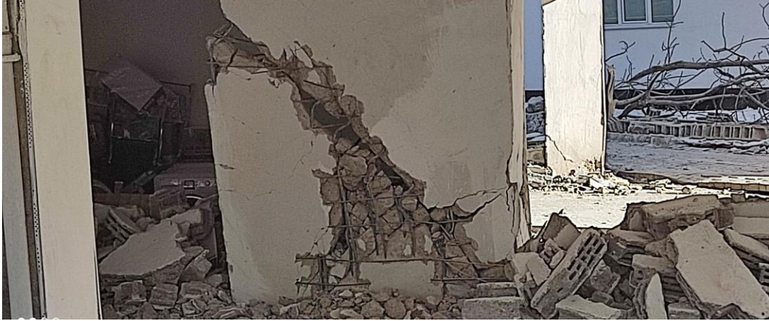
Şekil 33. Kesme Kuvvetinden Kaynaklı Hasar
